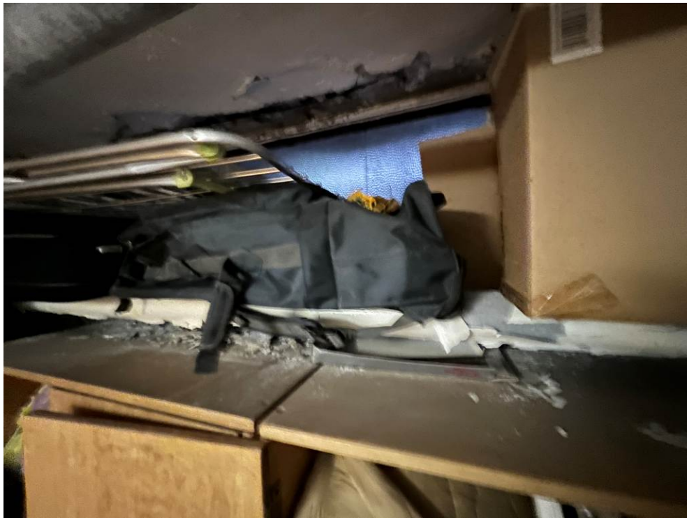
Fotografia n. 18 – Particolare del serramento del primo locale, che affaccia nella bocca di lupo
