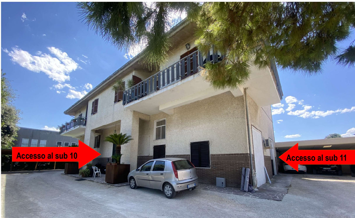
Vista del fabbricato dalla corte
