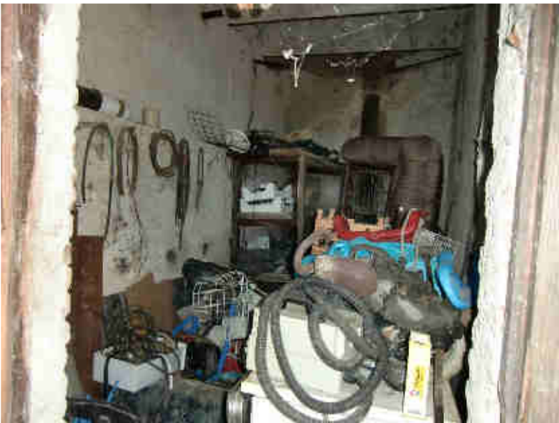
INTERNO DEL FABBRICATO
