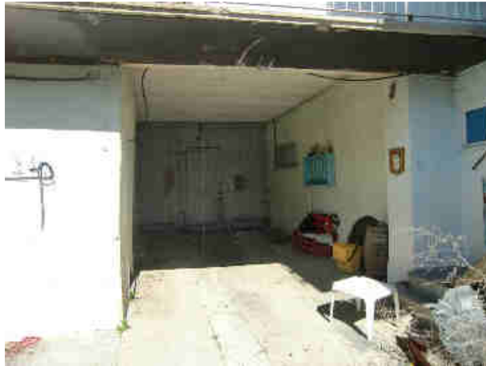
ANDRONE CARRAIO VISTO DAL CORTILE, UNICO ACCESSO CARRAIO ALLA PROPRIETA'
