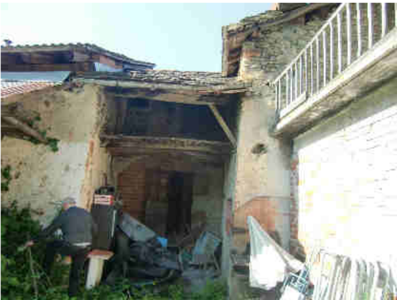
VISTA DA INTERNO CORTILE
