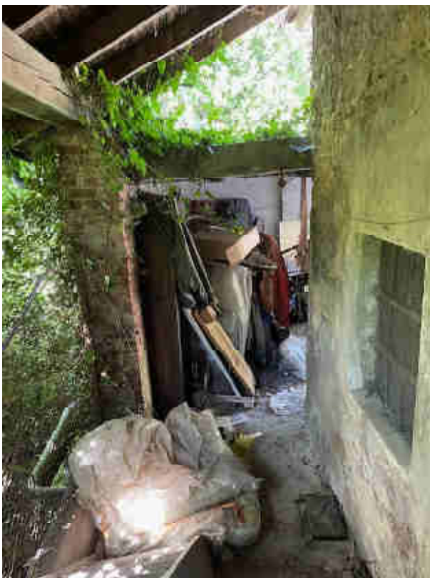
PORZIONE DI TETTOIA
