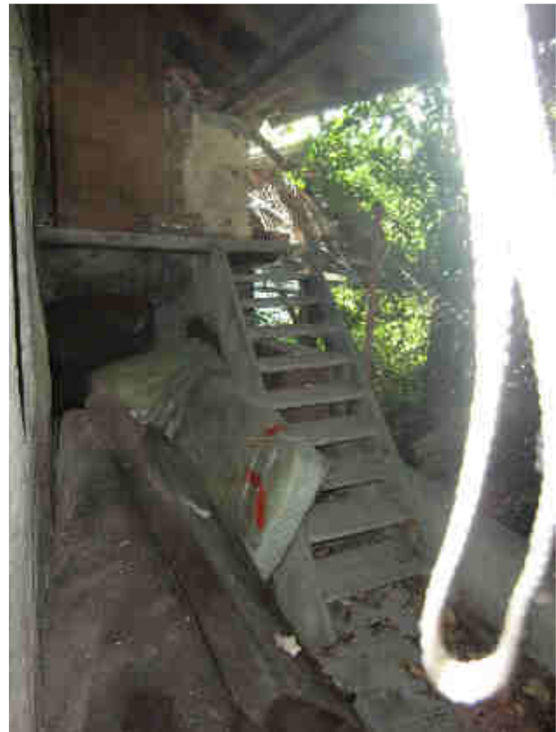
SCALA D'ACCESSO AL SOTTOTETTO
