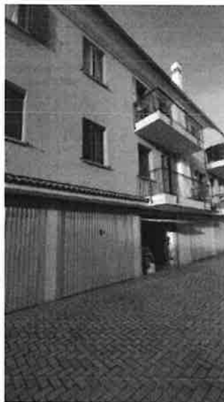
FOTO 14: vista prospetto sud
