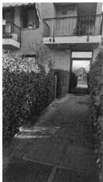
FOTO 1: vista prospetto nord
