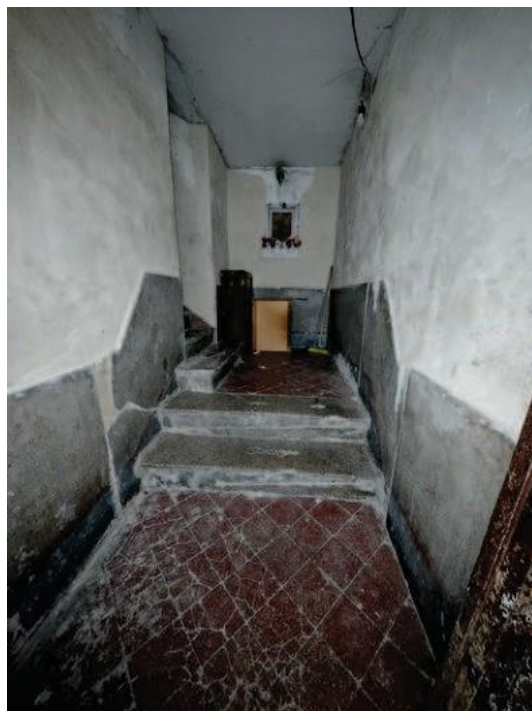
Ingresso su scala comune di accesso ai piani
