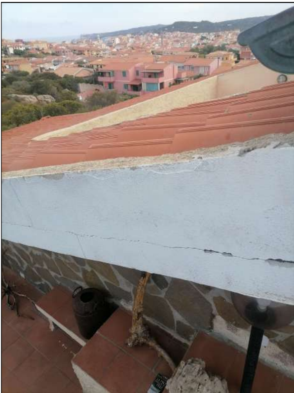
Foto: accesso al piano primo/sottotetto
