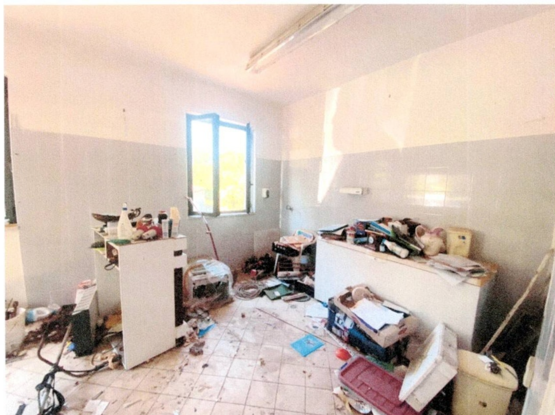
FOTO N.2 – LOCALE VENDITA E LAVORAZIONE CARNI (PRUNETTO F.10 N.38 SUB.5) F.10 N.317 SUB.1 F.10 N.353 SUB.1
