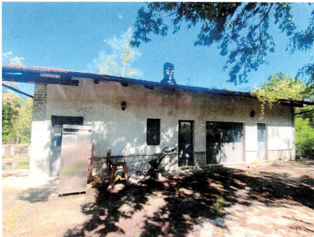
FOTO N.1 – PROSPETTO SUD/EST FABBRICATO LOCALI VENDITA E LAVORAZIONE CARNI (PRUNETTO F.10 N.38 SUB.5) F.10 N.317 SUB.1 F.10 N.353 SUB.1
