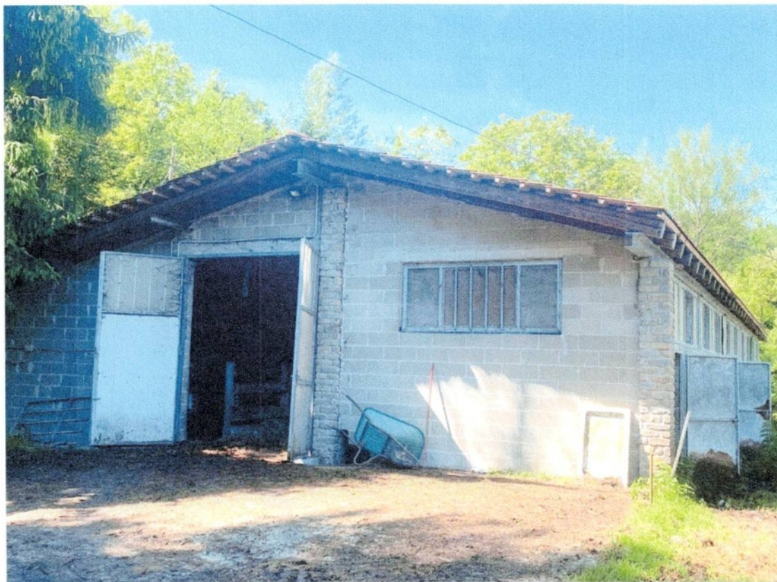
FOTO N.6 – PROSPETTO NORD/OVEST LOCALE STALLA AL PIANO TERRENO (PRUNETTO F.10 N.38 SUB.5) F.10 N.317 SUB.1 F.10 N.353 SUB.1
