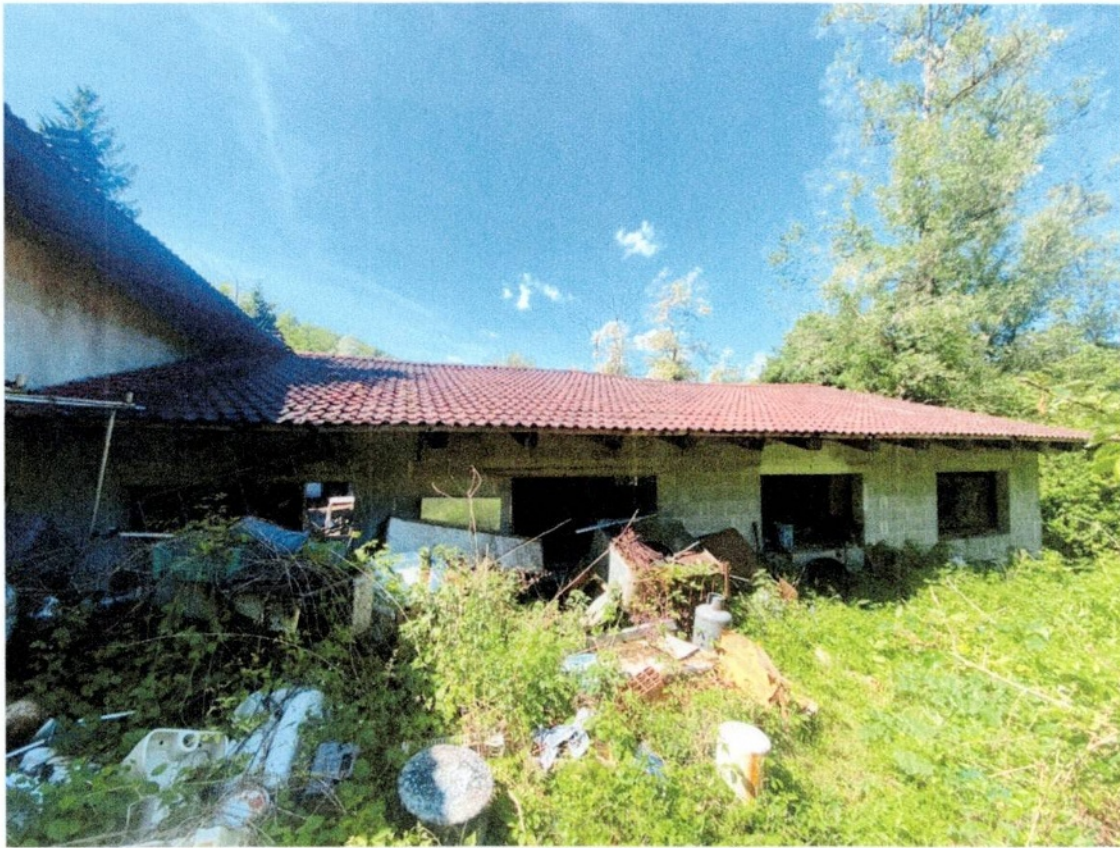
FOTO N.5 – PROSPETTO NORD FABBRICATO PORTICATO E LOCALE FIENILE AL PIANO PRIMO (PRUNETTO F.10 N.38 SUB.5) F.10 N.317 SUB.1 F.10 N.353 SUB.1
