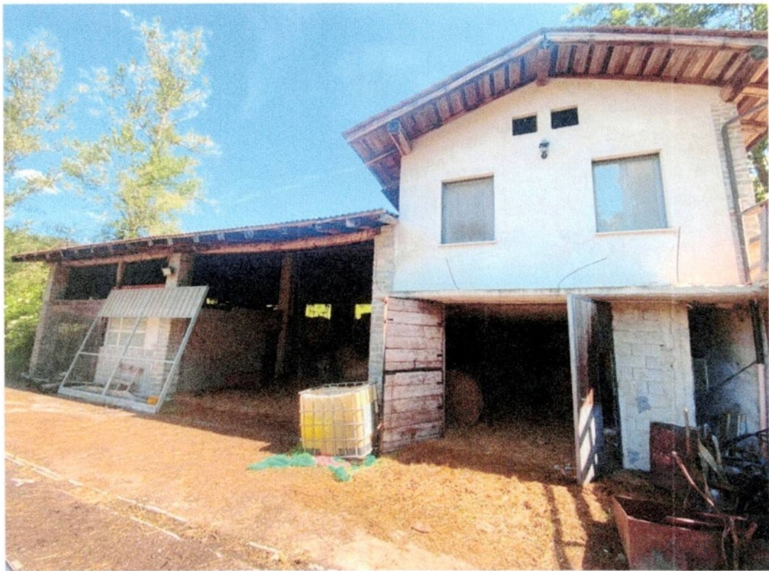
FOTO N.4 – PROSPETTO SUD FABBRICATO LOCALE DEPOSITO, PORTICATO E SGOMBERO AL PIANO TERRENO LOCALE FIENILE E LOCALE VENDITA E LAVORAZIONE CARNI AL PIANO PRIMO (PRUNETTO F.10 N.38 SUB.5) F.10 N.317 SUB.1 F.10 N.353 SUB.1
