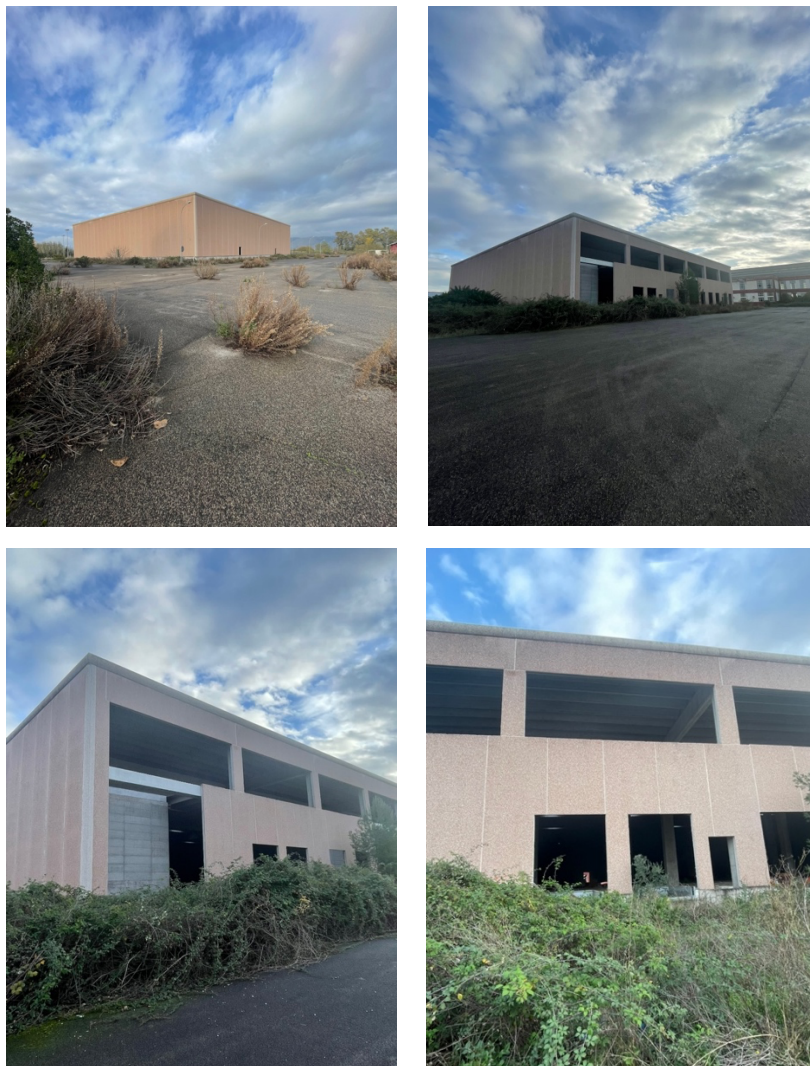
Figura 3 – Capannone industriale: stato di fatto
