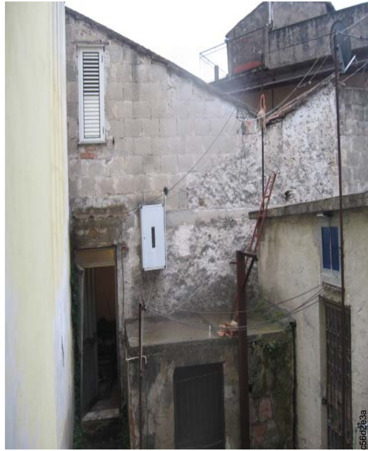
FOTO N. 2 – Prospetto lato ovest
