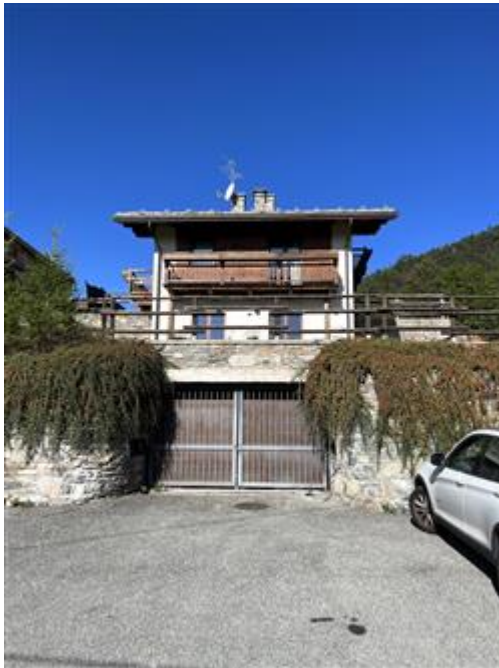
Ingresso Autorimessa Piano S2
