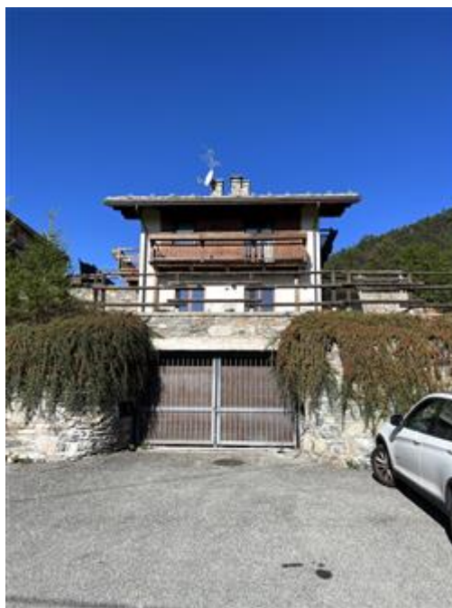
Ingresso Autorimessa Piano S2
