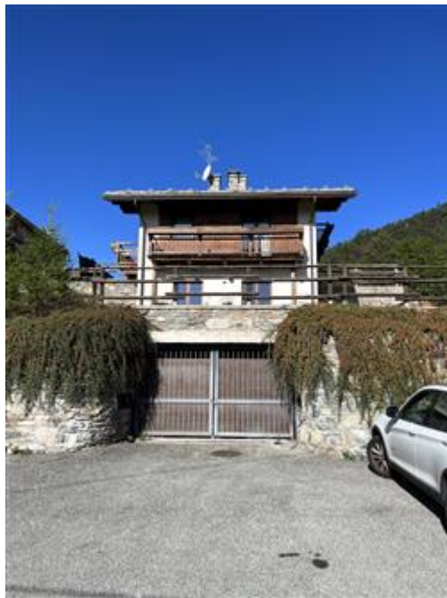
Ingresso Autorimessa Piano S2
