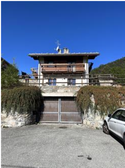
Ingresso Autorimessa Piano S2
