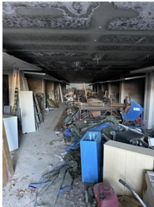
Corsia Comune Autorimesse Piano S2
