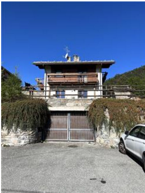
Ingresso Autorimessa Piano S2
