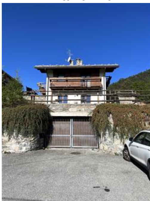
Ingresso Autorimessa Piano S2
