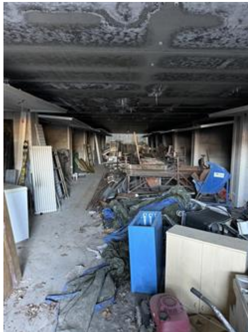
Corsia Comune Autorimesse Piano S2
