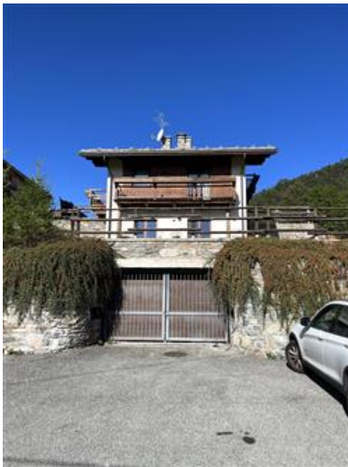
Ingresso Autorimessa Piano S2
