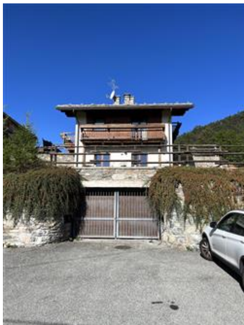
Ingresso Autorimessa Piano S2
