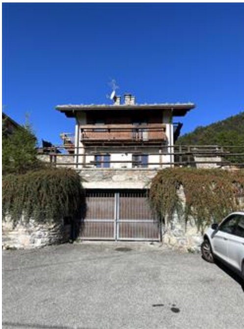
Ingresso Autorimessa Piano S2
