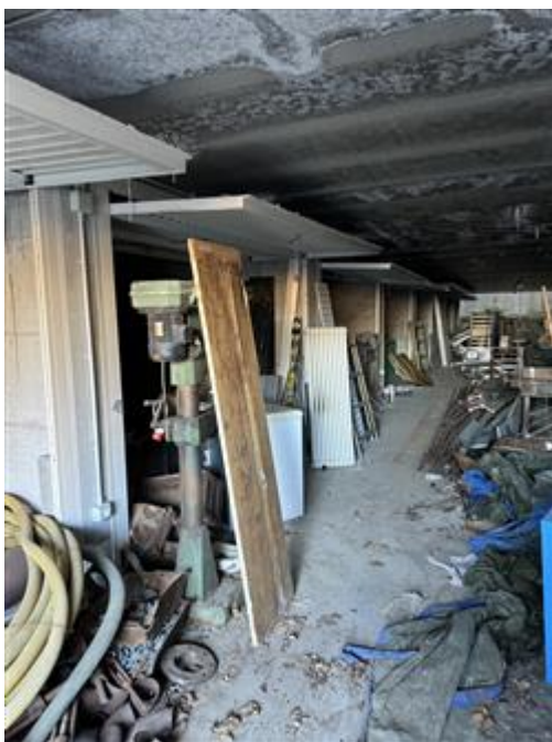
Corsia Comune Autorimesse Piano S2
