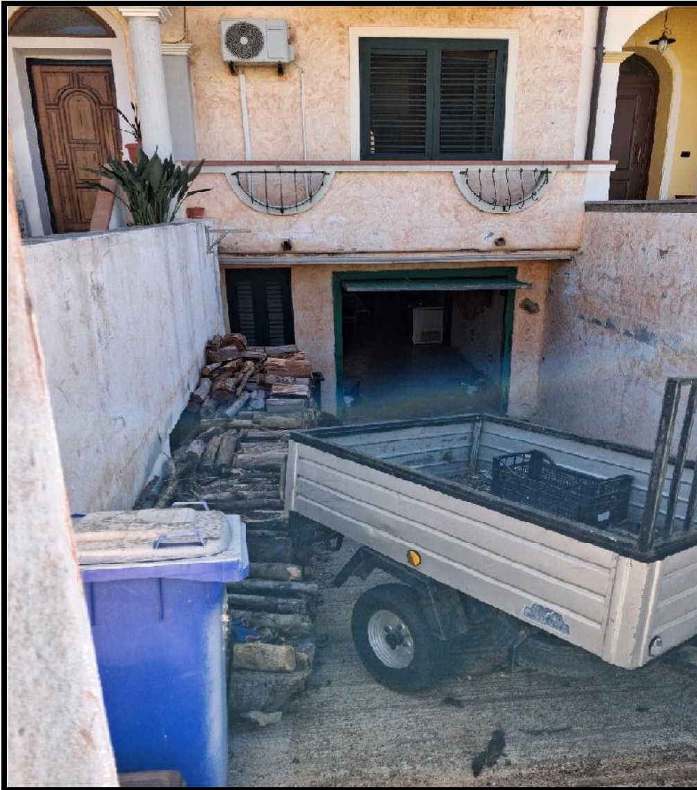
FOTO 2- ingresso al seminterrato.
