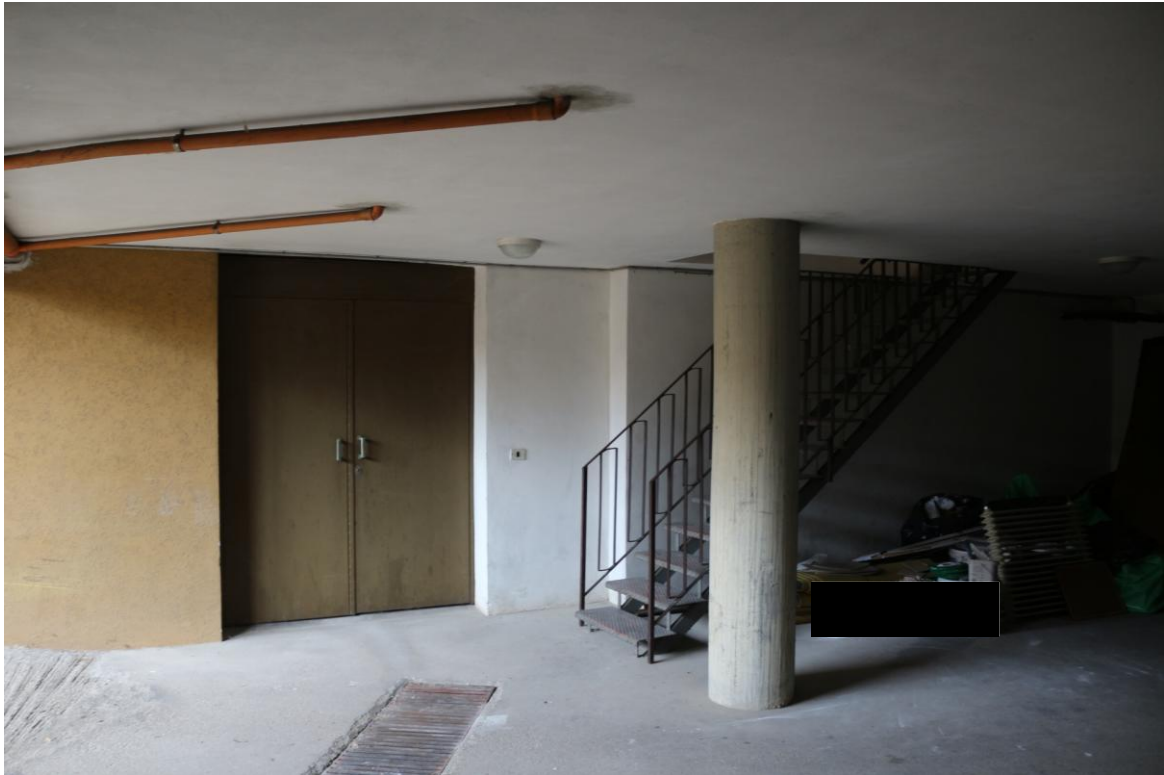
FOTO N°10. - visione interna – MAGAZZINO (PORTA DI ACCESSO)
