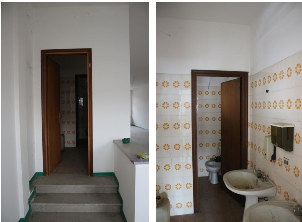
FOTO N°8. - visione interna - NEGOZIO
