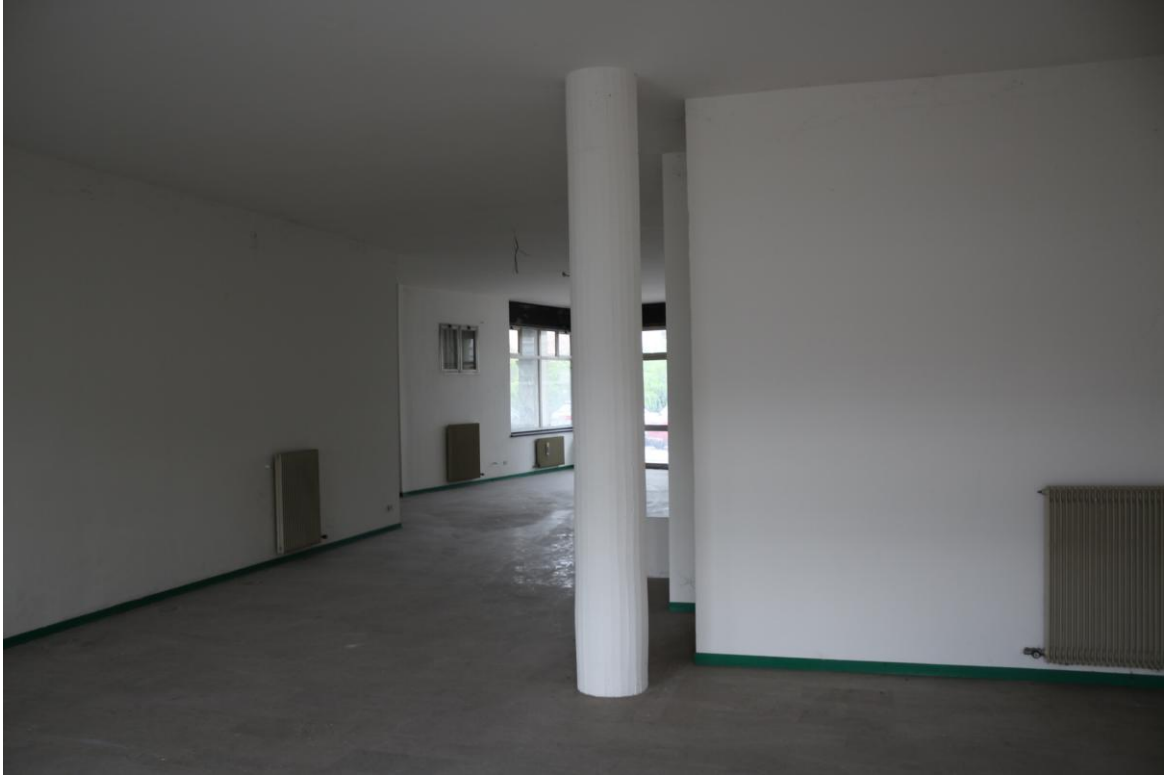
FOTO N°5. - visione interna - NEGOZIO
