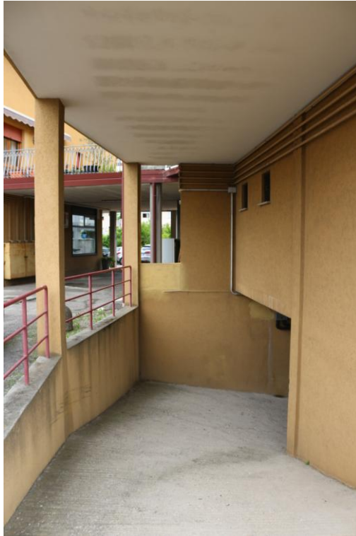
FOTO N°9. - visione interna – MAGAZZINO (RAMPA DI ACCESSO ALL'INTERRATO)
