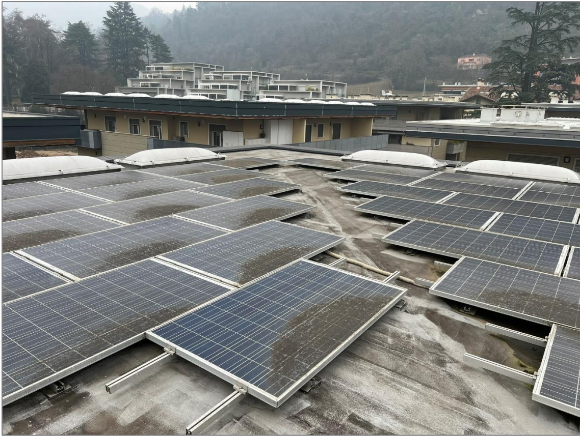
Figura 2 - Stato del campo fotovoltaico in copertura - lato N/NE
