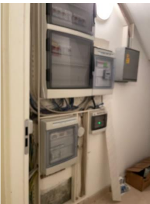
ingr. deposito s. 4
