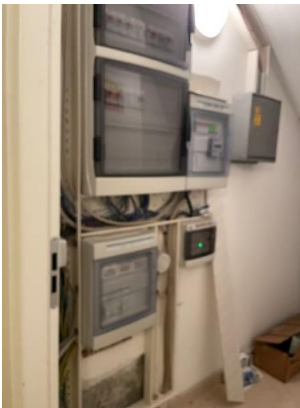
ingr. deposito s. 4
