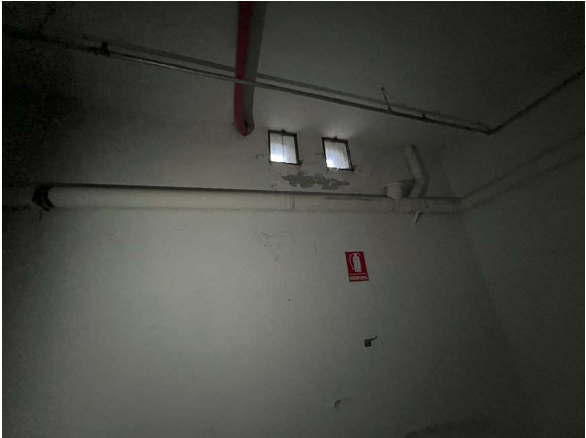
Foto 6. - Aperture lato sud
