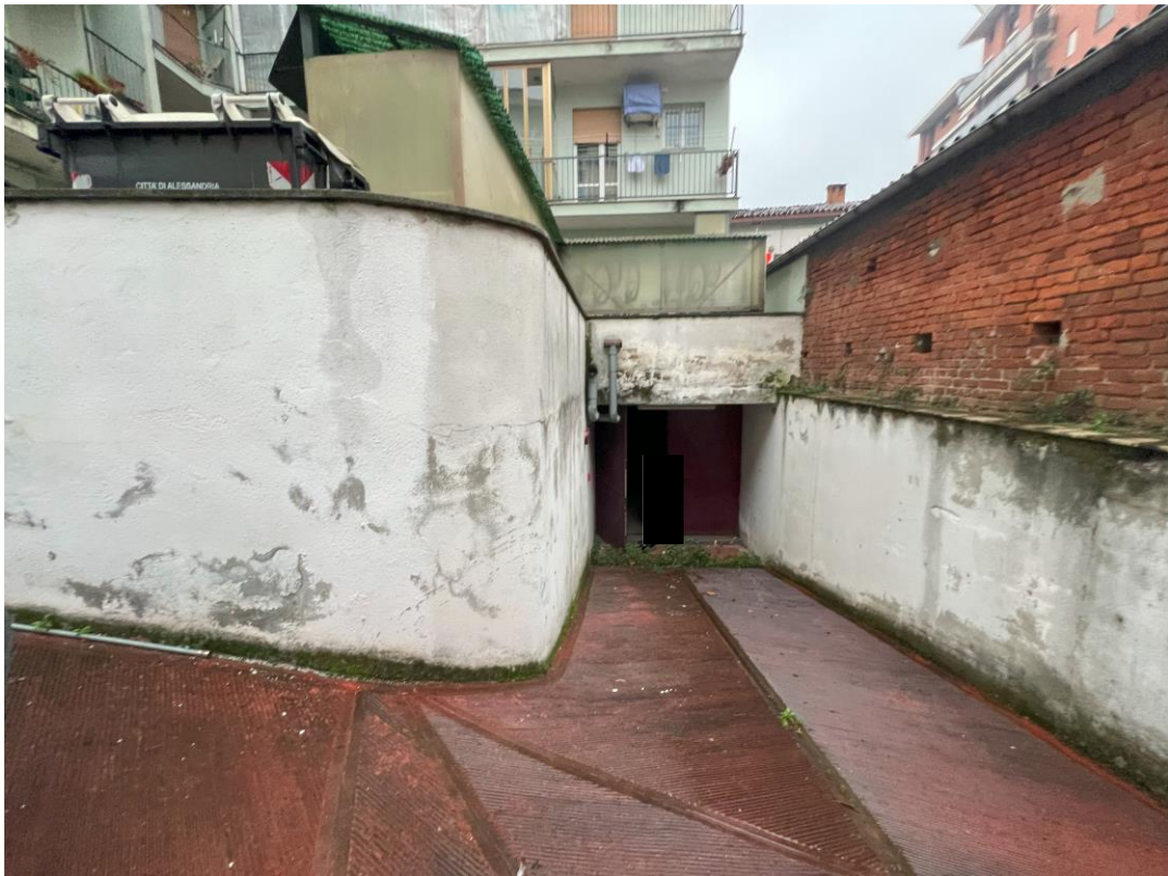
Foto 2. - Rampa con portone di ingresso
