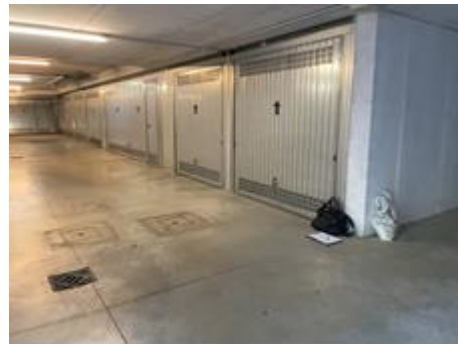
ingresso autorimessa s. 12 – area di manovra
