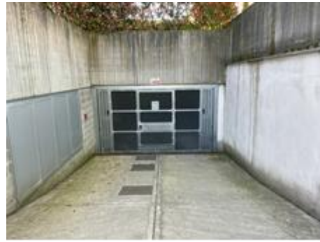
ingresso rampa carraia
