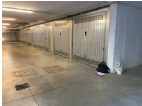
ingresso autorimessa s. 12 – area di manovra
