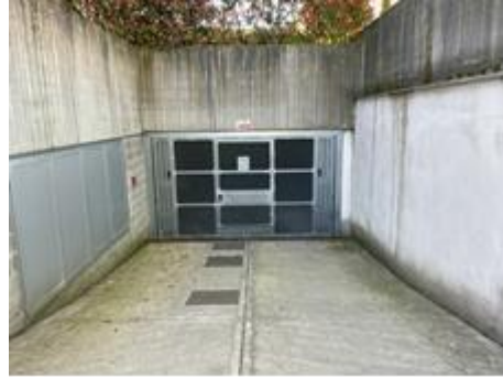
ingresso rampa carraia
