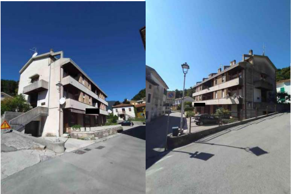
1. via Rujo vista da Est
