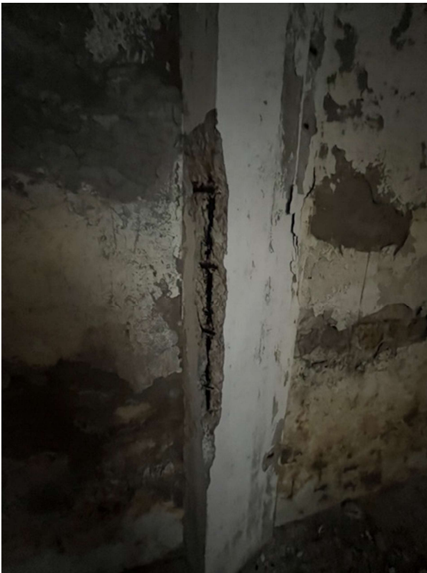
Foto 7. Box interno, particolare pilastro con ferri armatura ossidati
