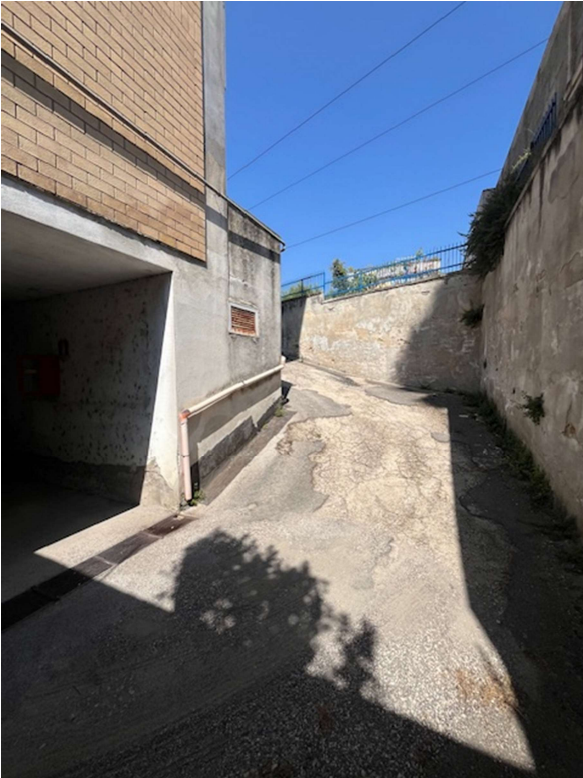
Foto 1. Rampa accesso esterna
