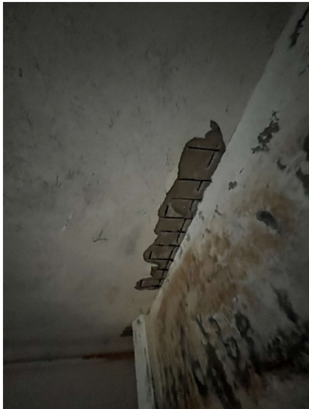
Foto 7. Box interno, particolare pilastro con ferri armatura ossidati
