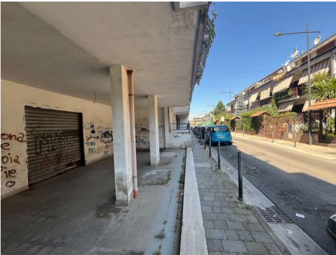
Foto 2. Locale commerciale: porticato esterno
