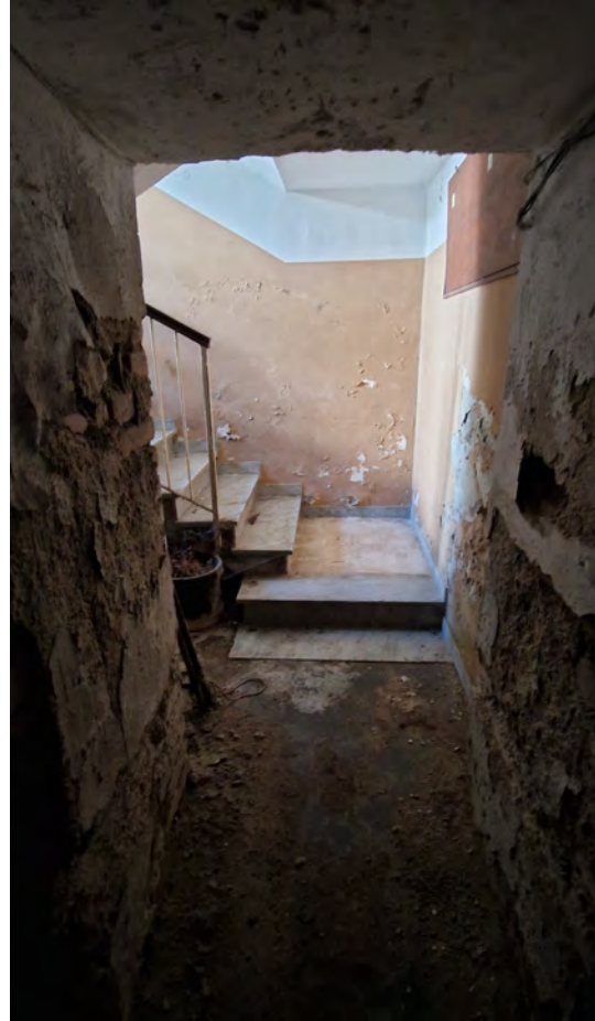
Disimpegno locali seminterrati
