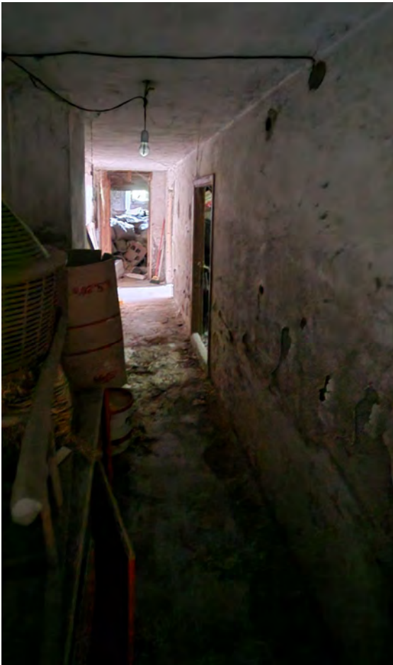
Disimpegno locali seminterrati
