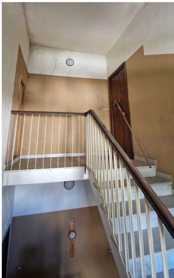
Vano scala condominiale
