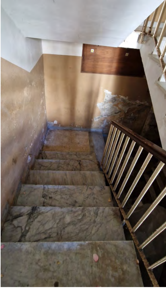
Vano scala di accesso a locali seminterrati
