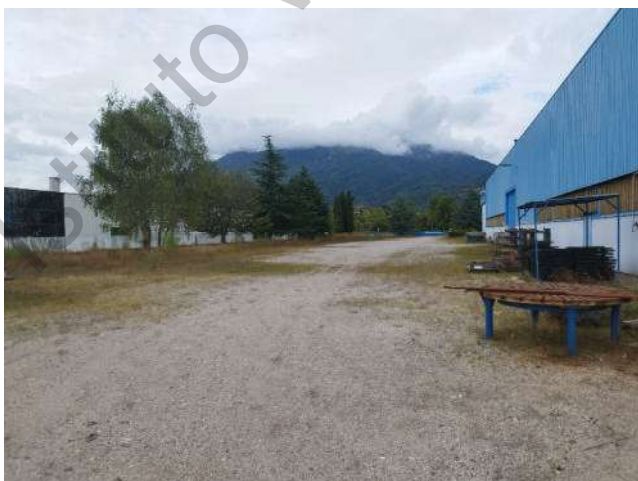
Vista esterna da sud-ovest
