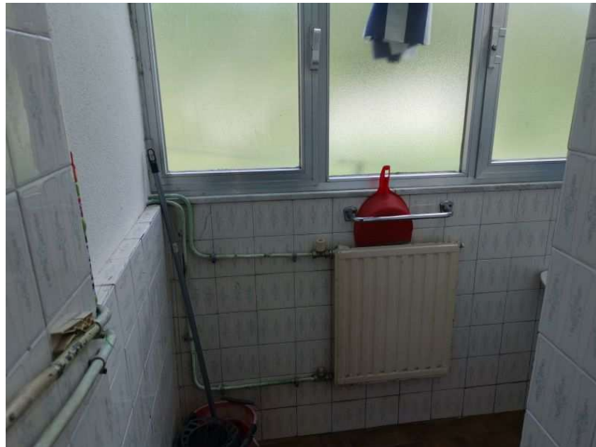
Foto 18 – Veranda piano primo
