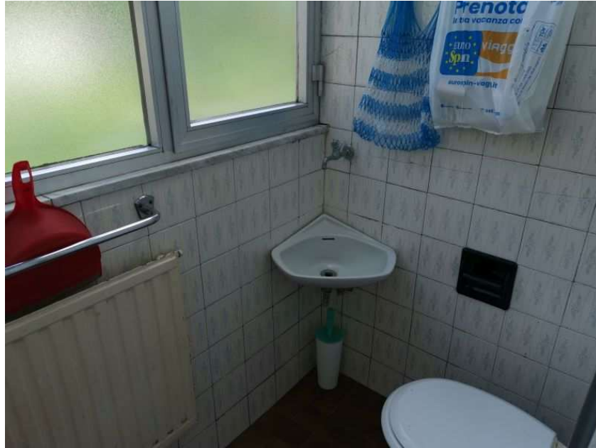
Foto 19 – WC piano primo
