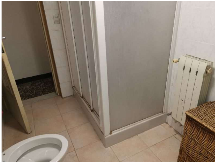
Foto 8 – Bagno piano terra
