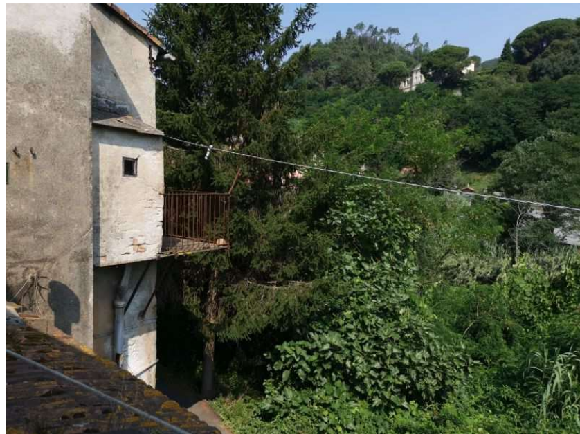
Foto 20 – Vista da veranda
