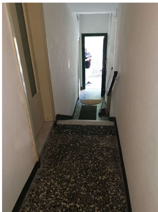
Foto 4 – Ingresso da vano scala
