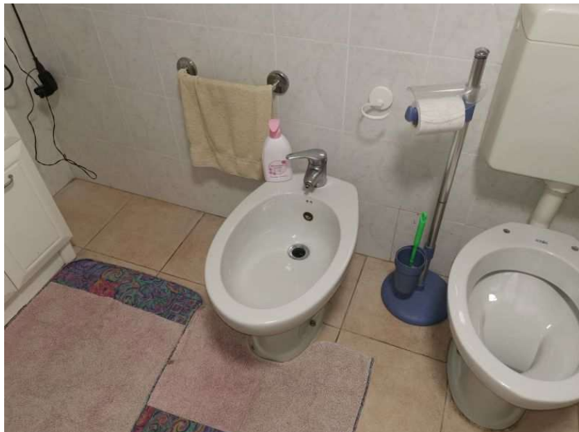
Foto 10 – Bagno piano terra
