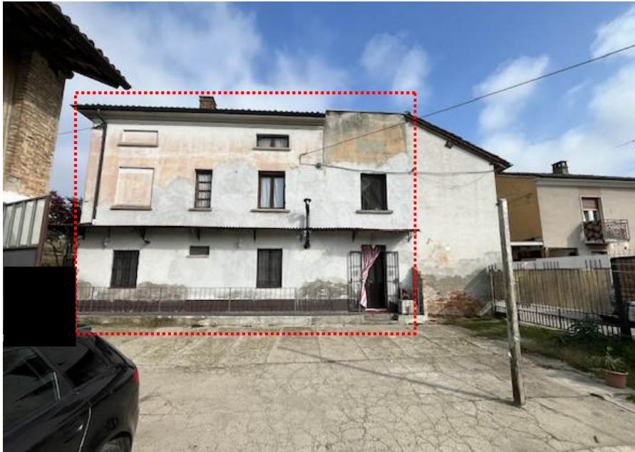
Vista del fabbricato principale dal cortile (in rosso la porzione di proprietà)
