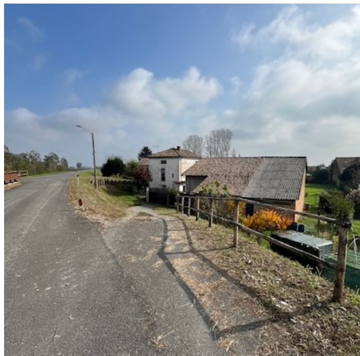
Vista del fabbricato dalla strada comunale dell'Isola delle Ghiaie (lato nord-ovest)
