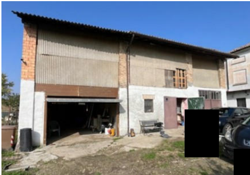
Vista del fabbricato accessorio dal cortile (portico, ripostiglio, lavanderia e cascino)
