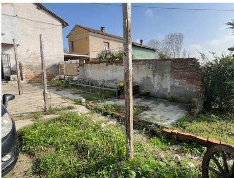
Vista della zona sud del cortile ove sorgevano le cantine, che ad oggi risultano demolite.
