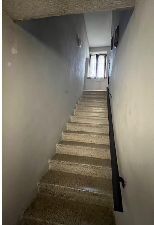
Scala di accesso al piano primo
