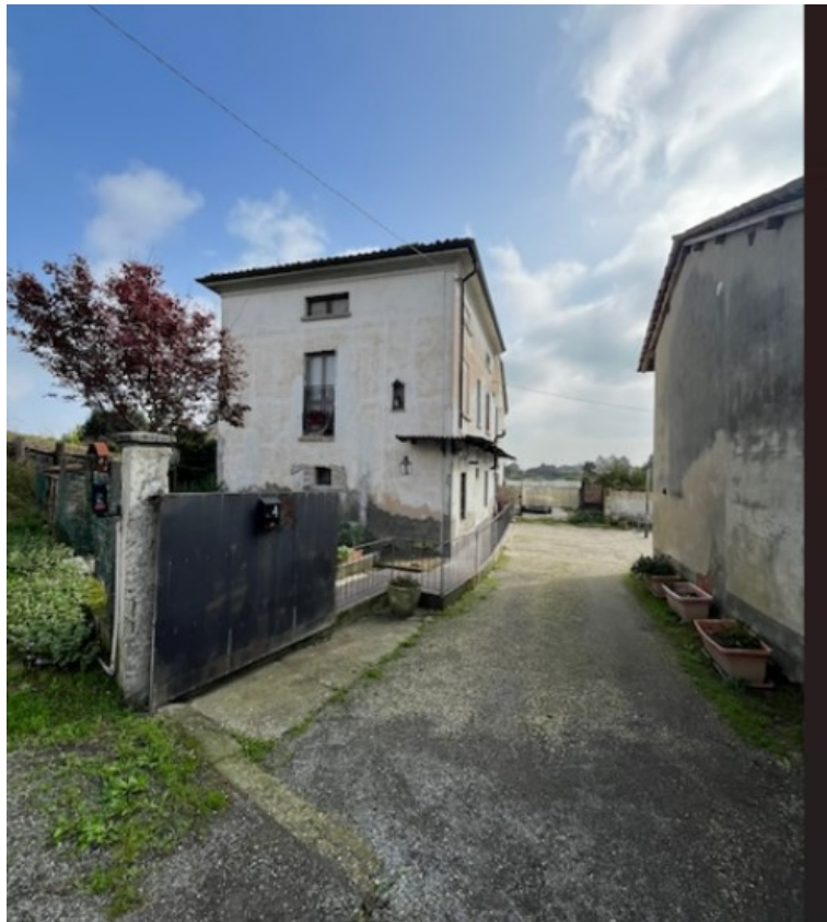
Vista accesso al fabbricato
