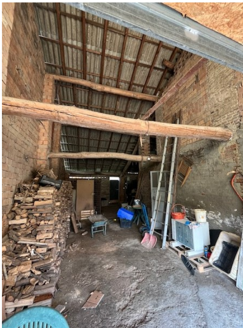
Fabbricato accessorio: piano terra lato ovest (loc. portico di plan. catastale)
