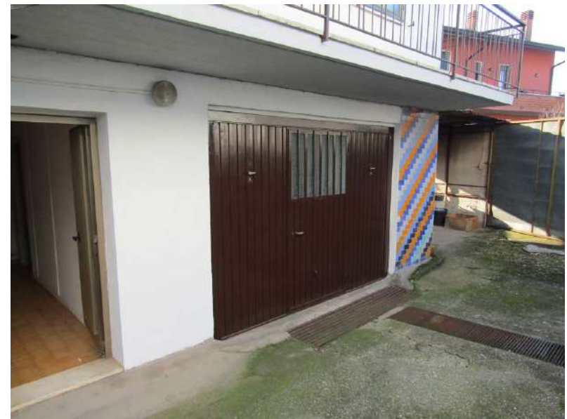
Foto 8: dettaglio dell'accesso all'autorimessa al piano terra
