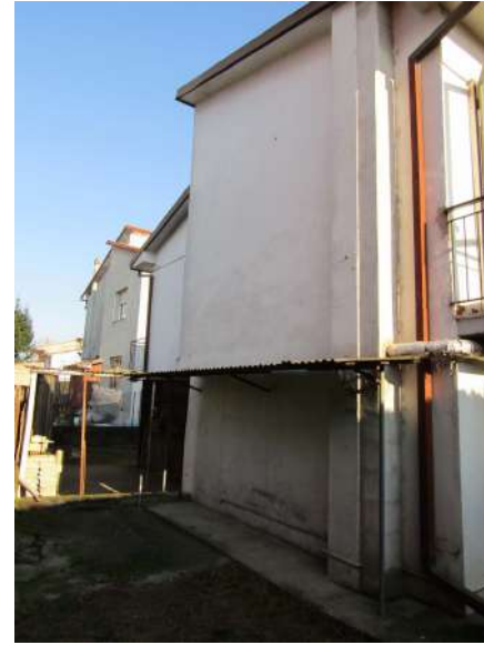
Foto 10: scorcio sul prospetto sud
