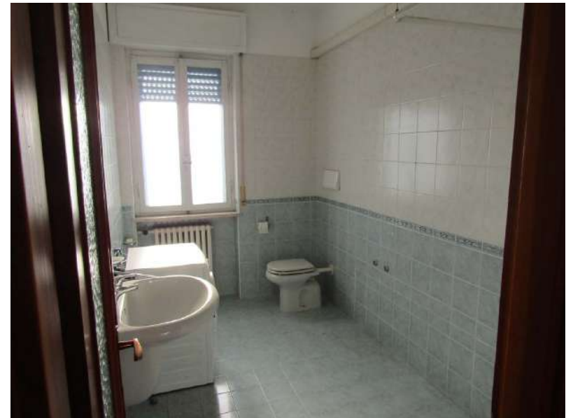
Foto 20: vista del bagno al primo piano
