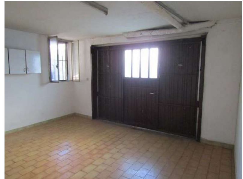
Foto 28 interno dell'autorimessa al piano terra
