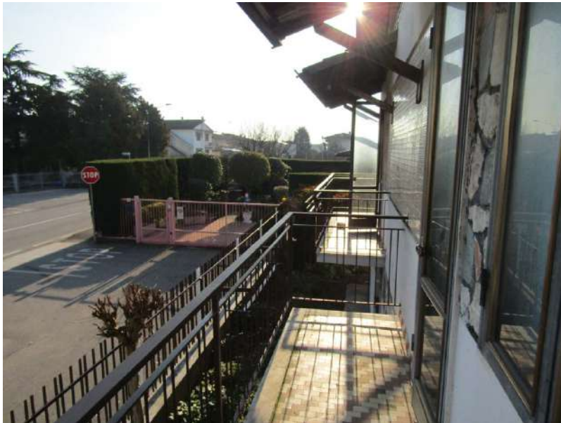
Foto 13: vista dei balconi sul lato nord
