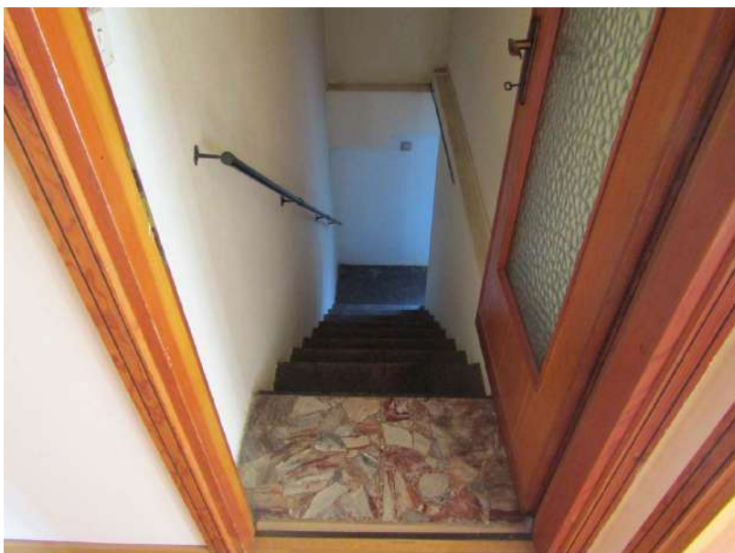
Foto 21: vista della scala interna
