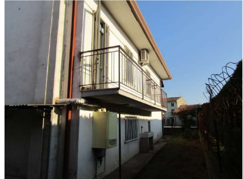
Foto 6: scorcio sul lato est dell'edificio (caldaia in primo piano)
