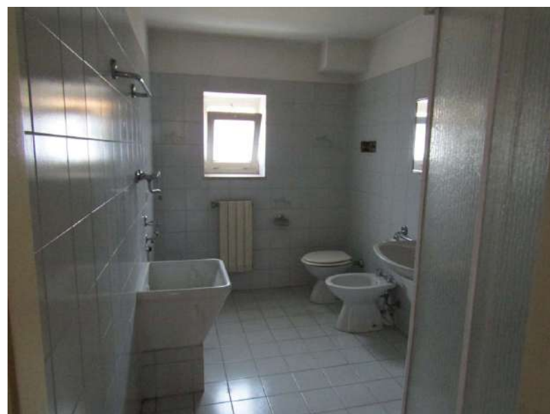
Foto 24 bagno al piano terra
