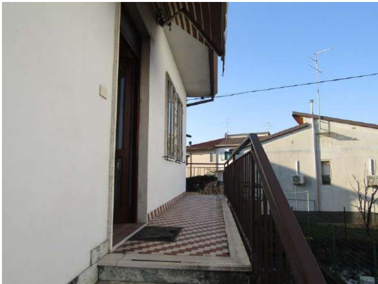
Foto 11: vista del balcone di accesso a ovest
