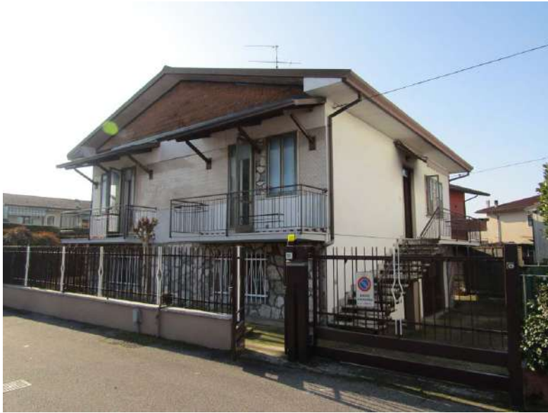
Foto 1: vista d'insieme dell'edificio da via Legnaghese da nord
