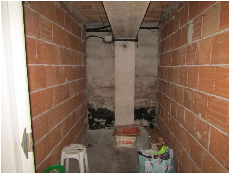
Foto 27: vista del ripostiglio al grezzo al piano terra
