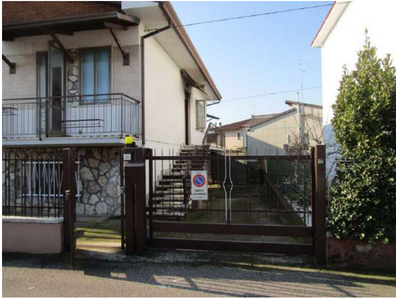
Foto 5: scorcio sul lato ovest con accessi carraio e pedonale
