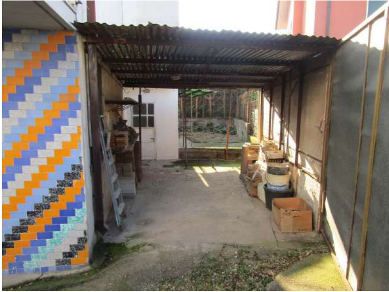
Foto 9: vista della tettoia uso box auto
