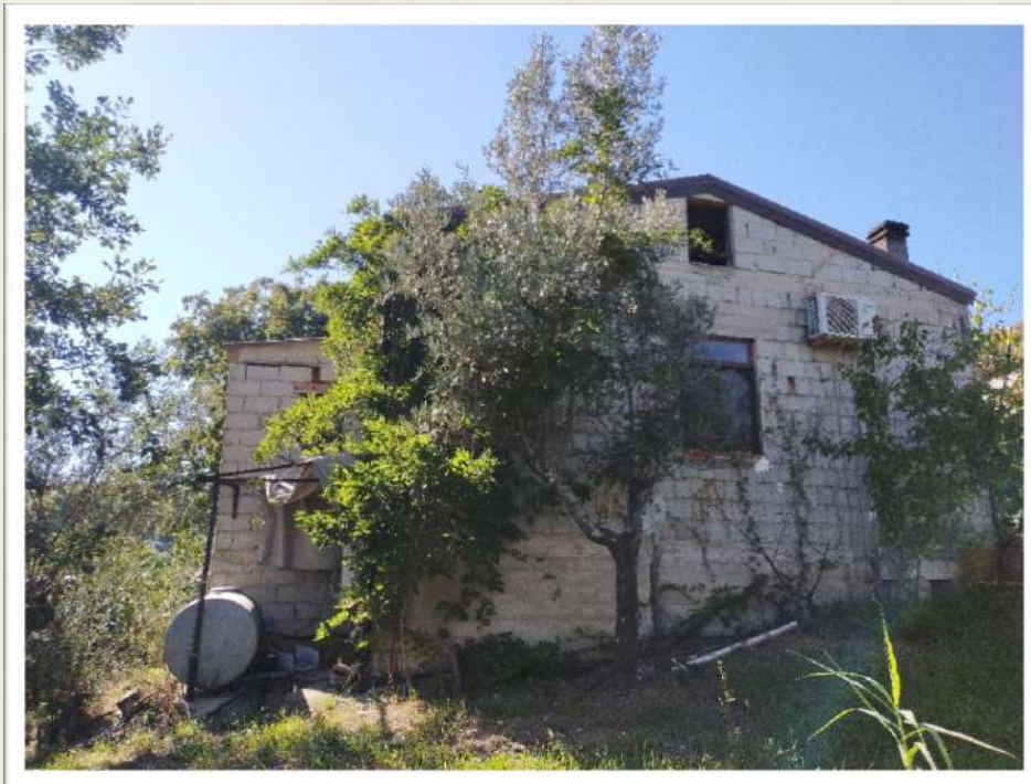
FOTO N° 19 - MAGAZZINO - FOGLIO 9 - PARTICELLA 203 - SUB 1
