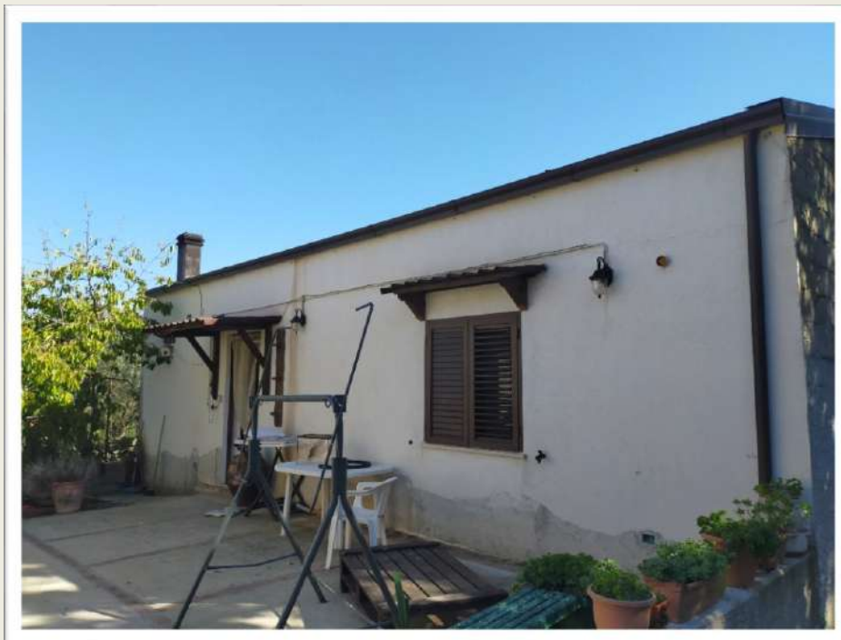
FOTO N° 17 - MAGAZZINO - FOGLIO 9 - PARTICELLA 203 - SUB 1
