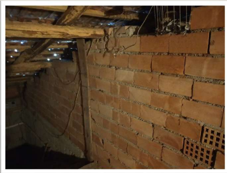
FOTO N° 16 - SOTTOTETTO - FOGLIO 9 - PARTICELLA 202 - SUB 1
