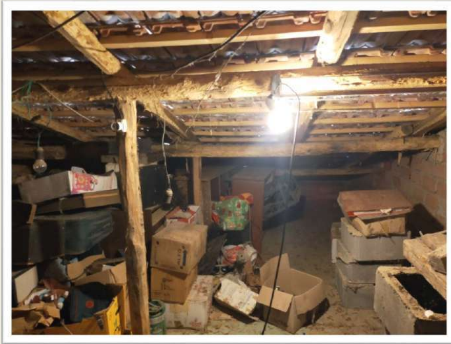
FOTO N° 15 - SOTTOTETTO - FOGLIO 9 - PARTICELLA 202 - SUB 1
