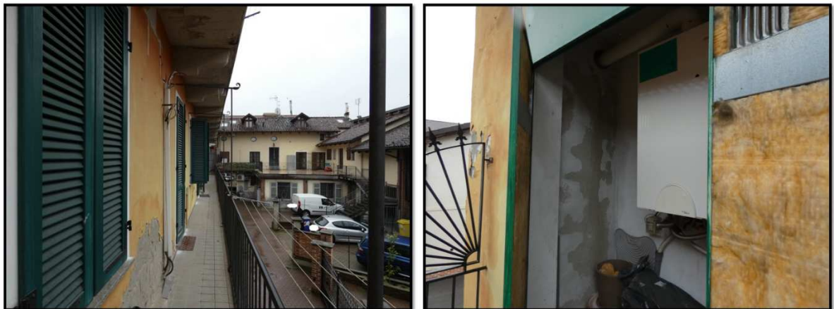
Foto 19 – 20 balcone d'accesso all'abitazione e generatore riscaldamento e ACS
