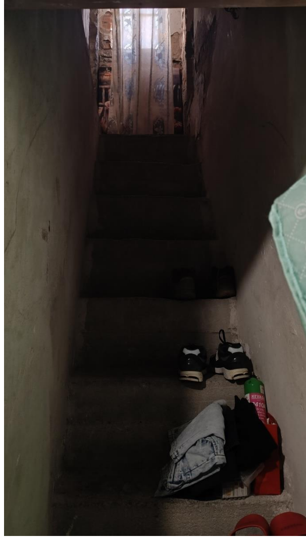
Accesso - Scala interna
