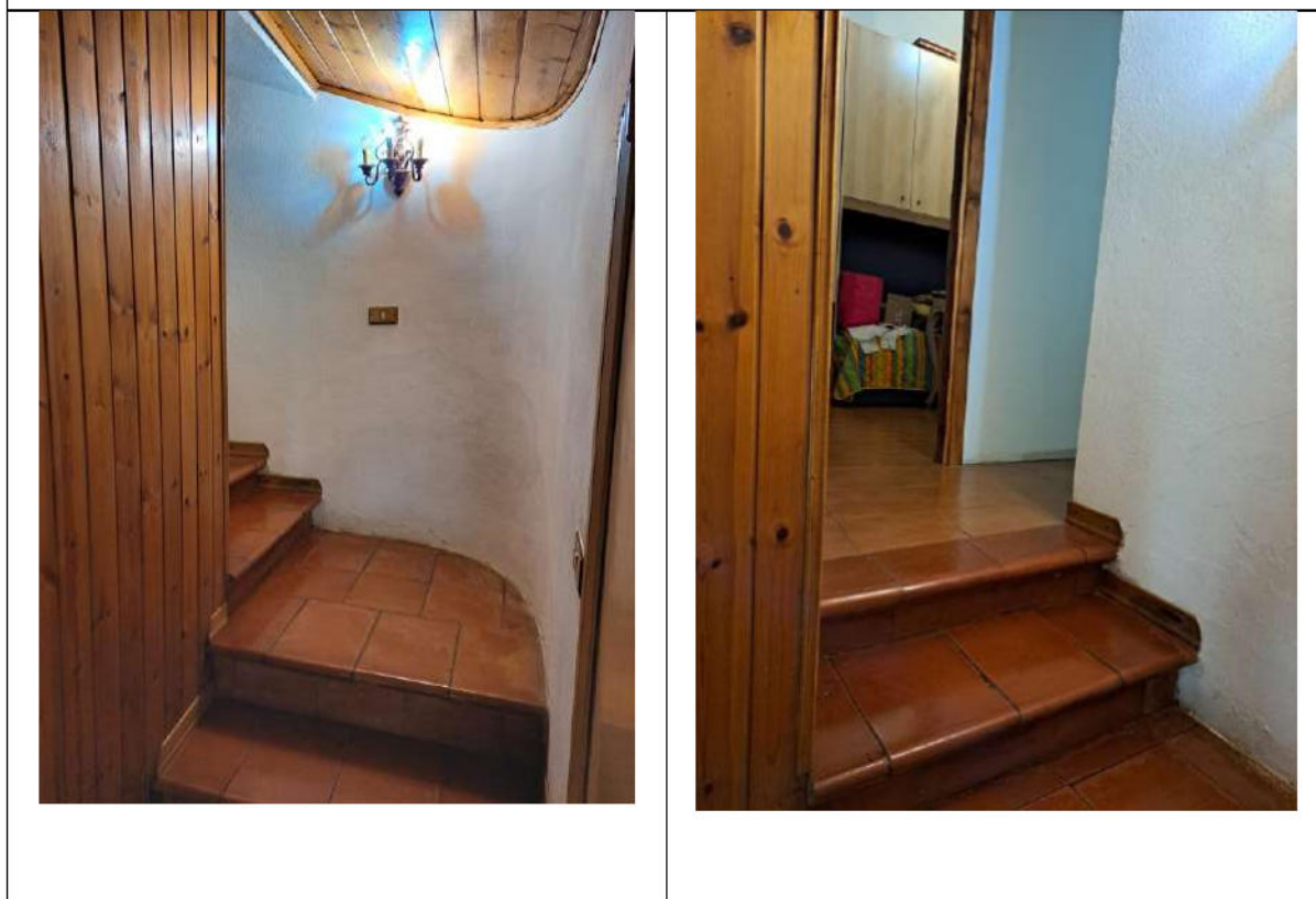
FOTO n°12 e n°13: gradini di collegamento dall'ammazzato al piano primo (camere).
