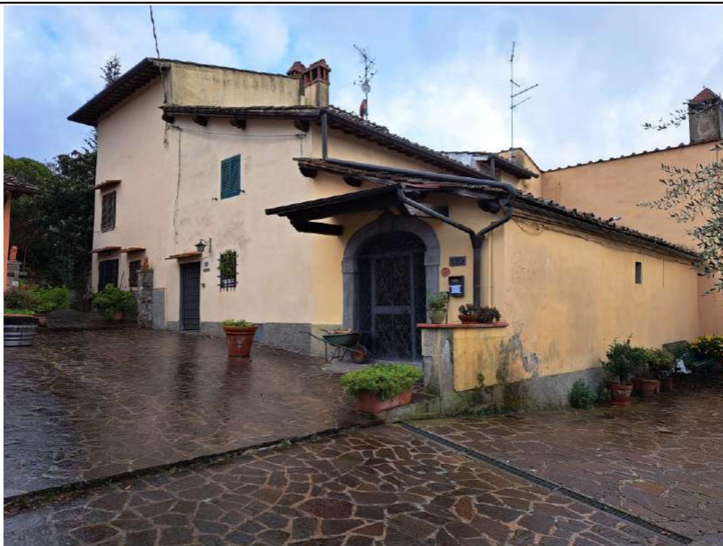
FOTO n°1: vedute esterne dal resede a comune d'ingresso FOTO n°2: particolare infisso in ferro e vetro d'ingresso all'abitazione.
