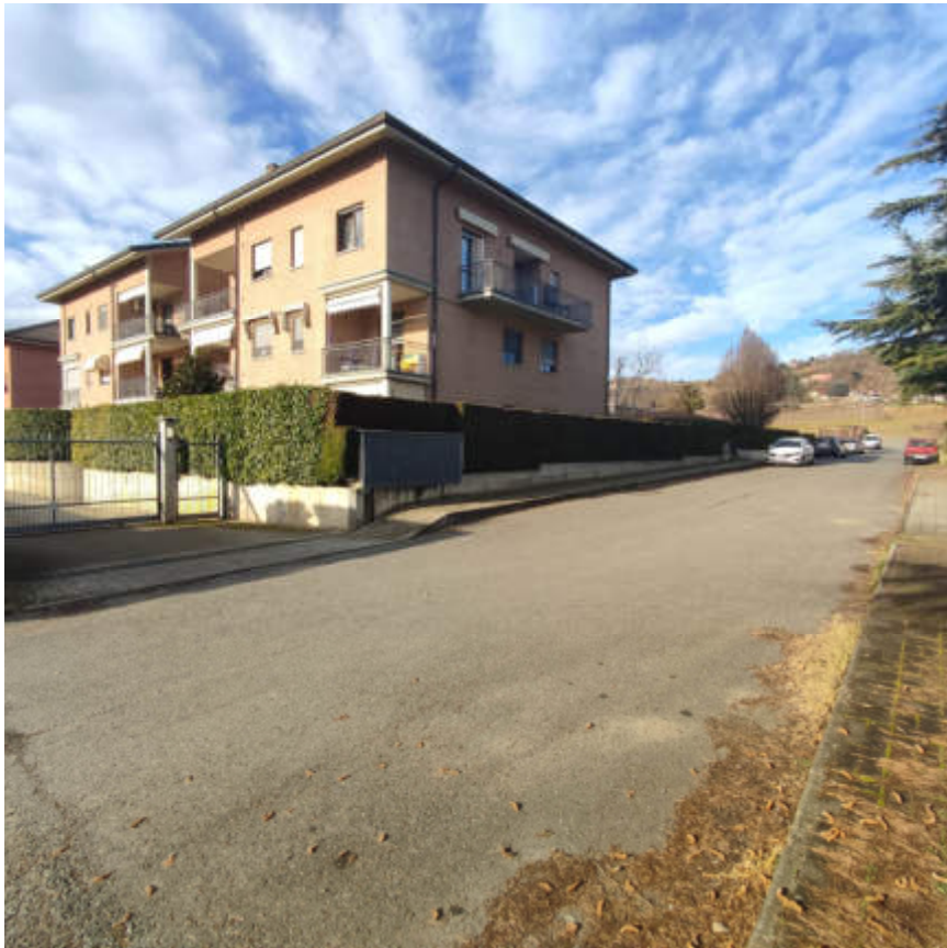
Vista dalla sede strada pubblica del cancello di accesso al cortile condominiale
