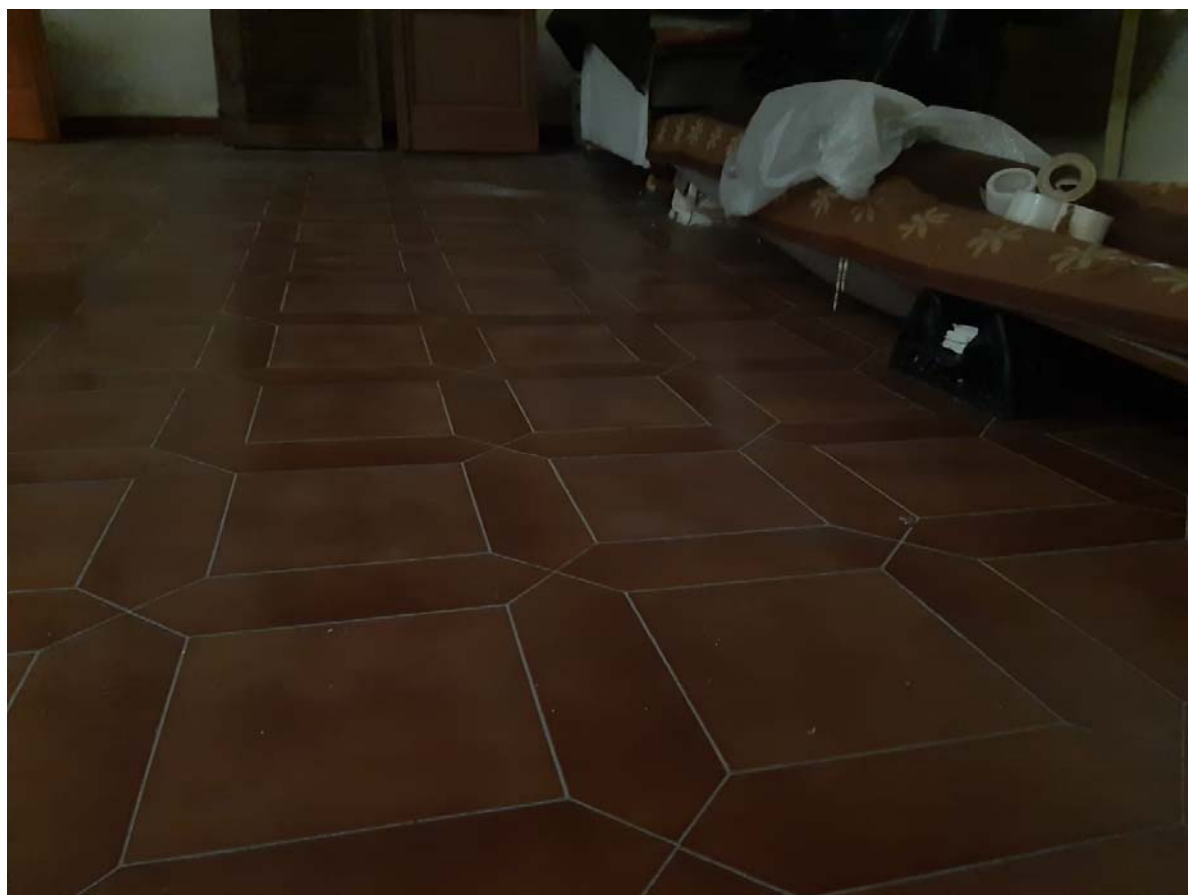
FOTO 12 : Particolare della parte di pavimento avvallata
