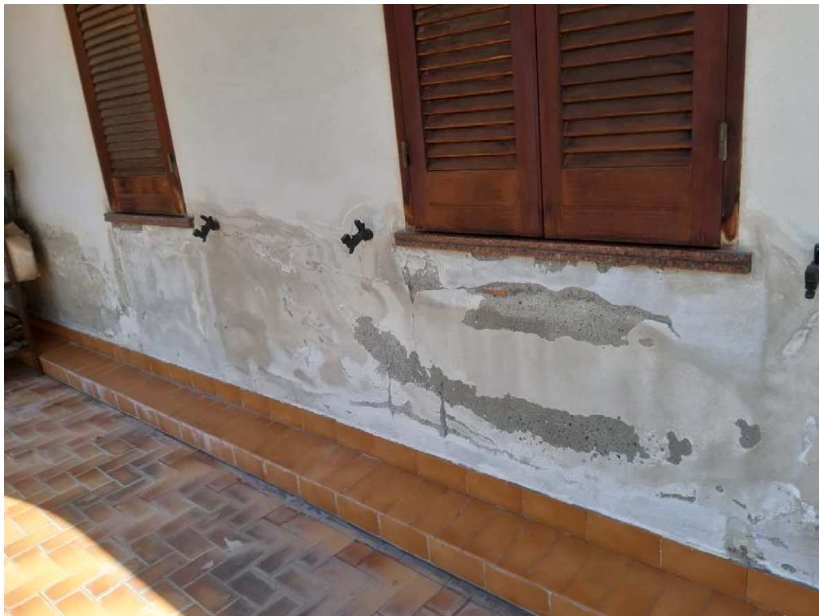
FOTO 10 : Scrostature e muffa da condensa
