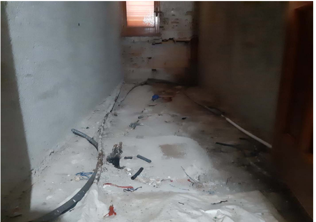
FOTO 8 : Il bagno in ristrutturazione
