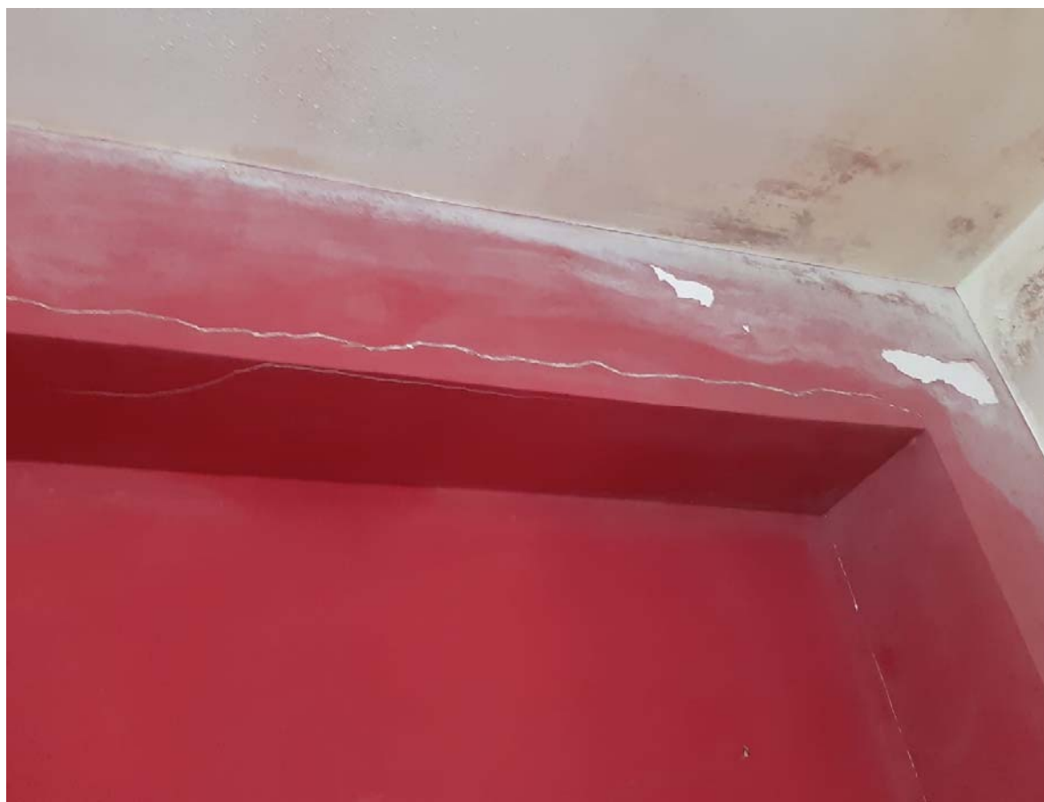
FOTO 10 : Scrostature e muffa da condensa
