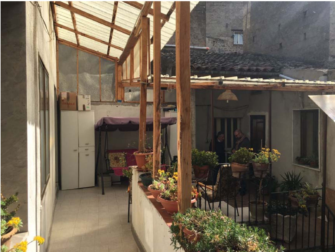
4_ballatoio primo piano e accessi all'abitazione
