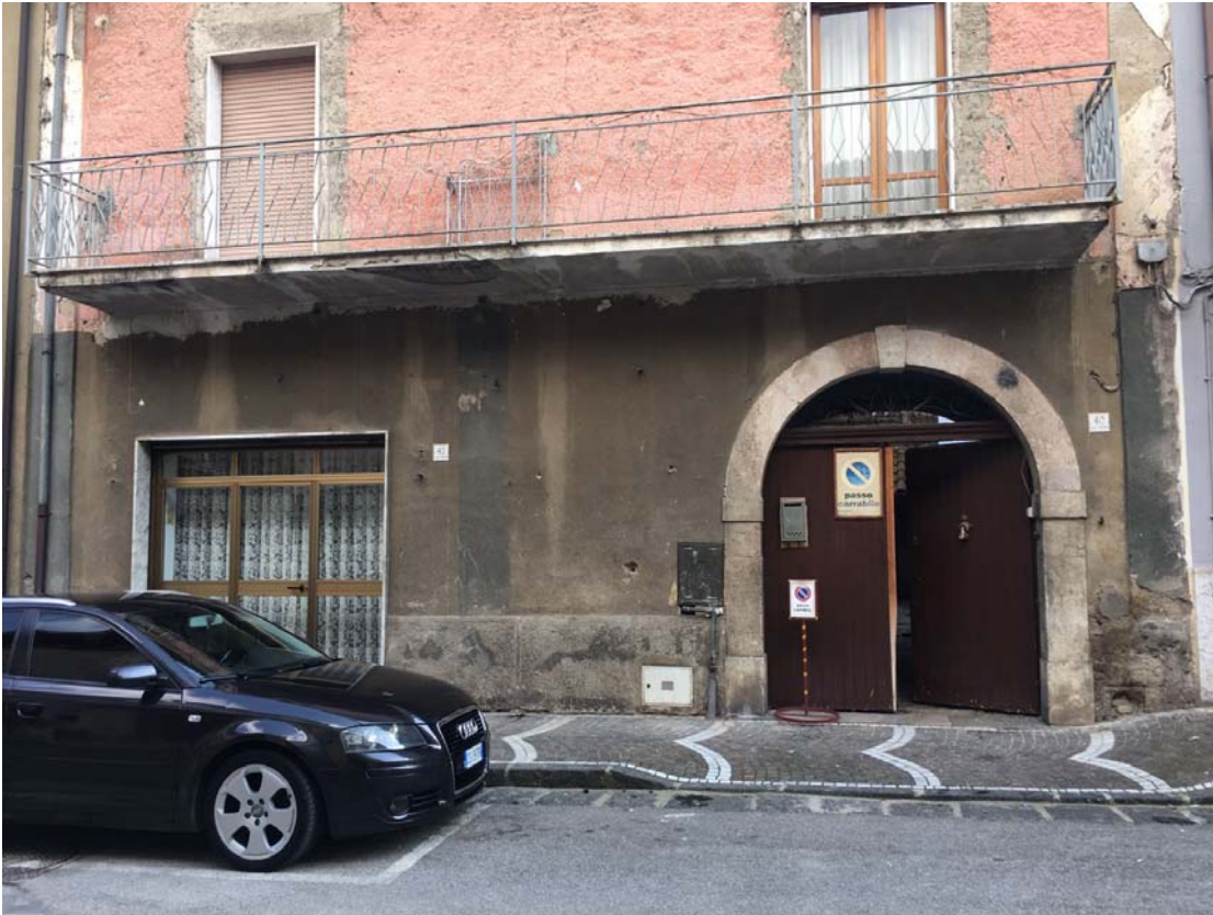
1_a sinistra il vano terraneo
