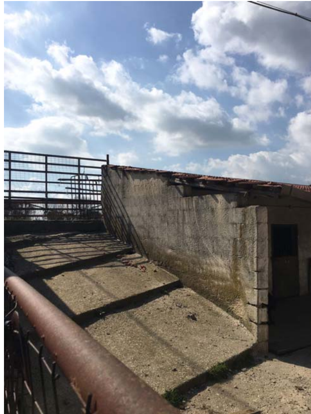
6_rampa carrabile di ingresso alla proprietà
