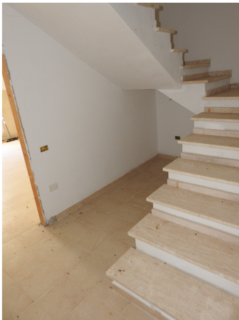
Figura 27 - Piano seminterrato, vano scala
