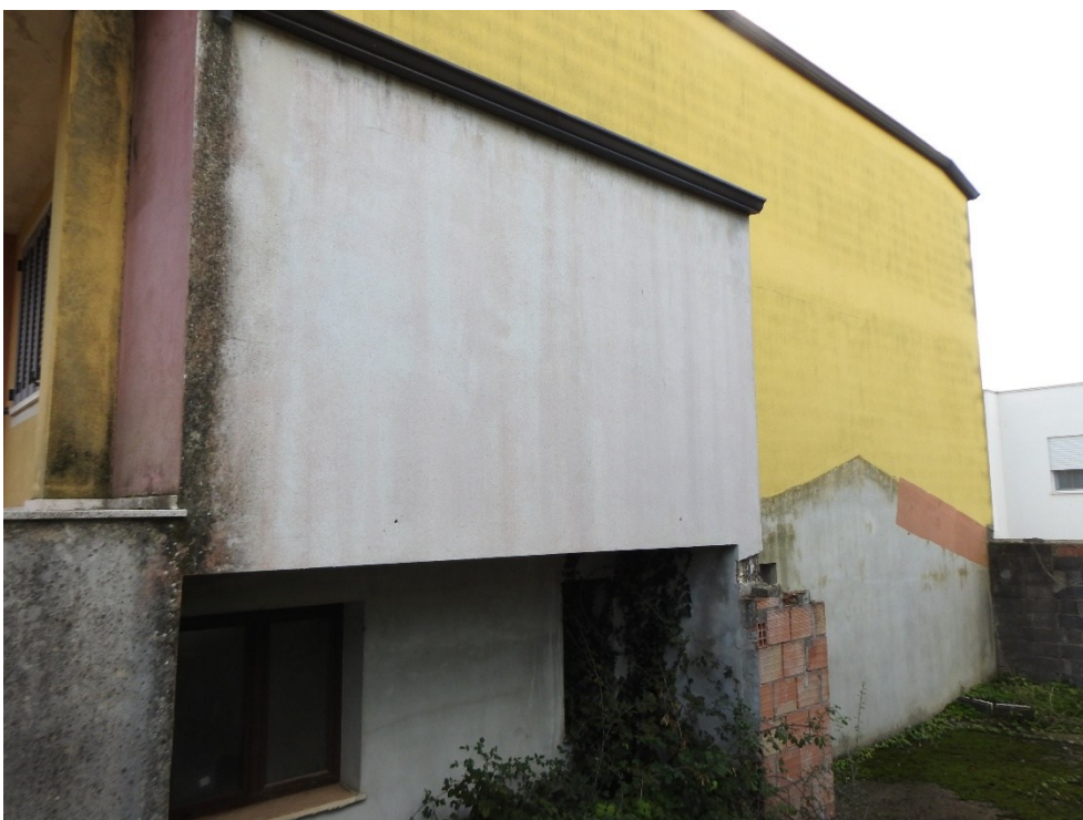
Figura 23 - Visuale complessiva del fabbricato dalle aree di pertinenza. Prospetto laterale nordovest
