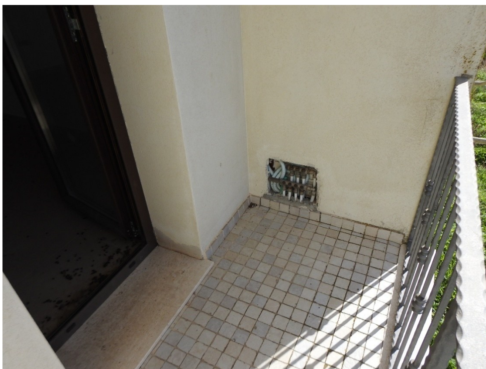
Figura 38 - Piano Terra, balcone cucina
