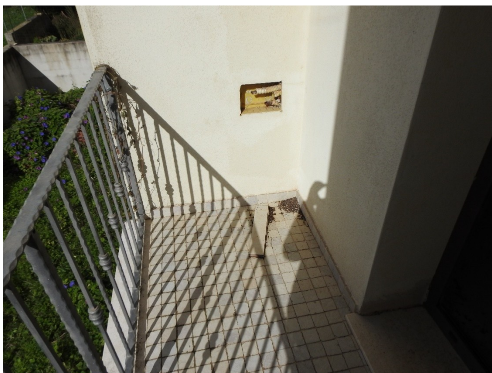
Figura 39 - Piano Terra, balcone cucina
