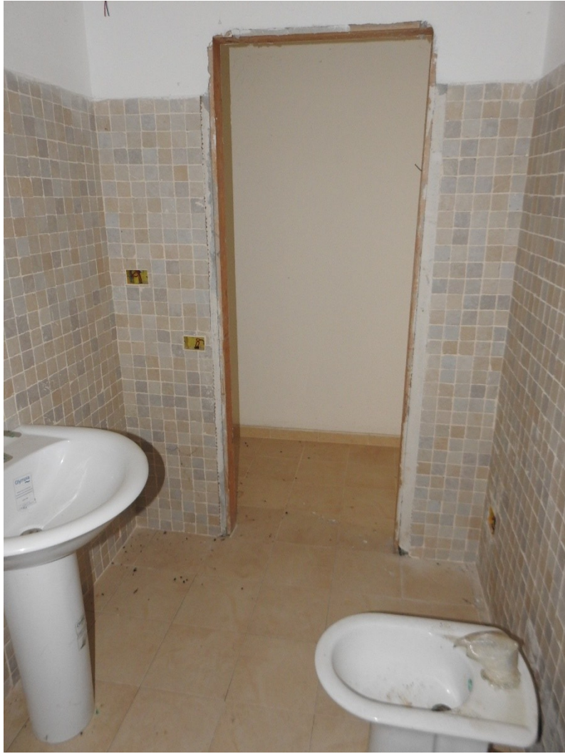
Figura 32 - Piano seminterrato, bagno
