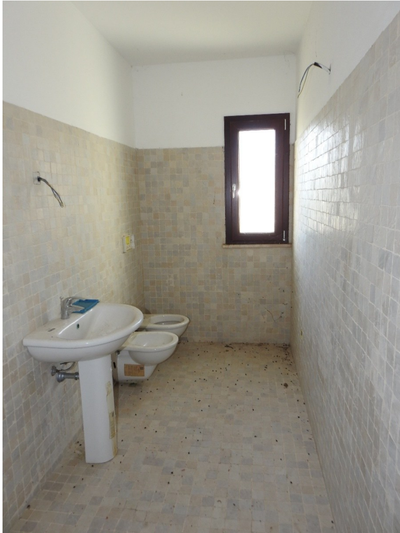
Figura 36 - Piano Terra, bagno
