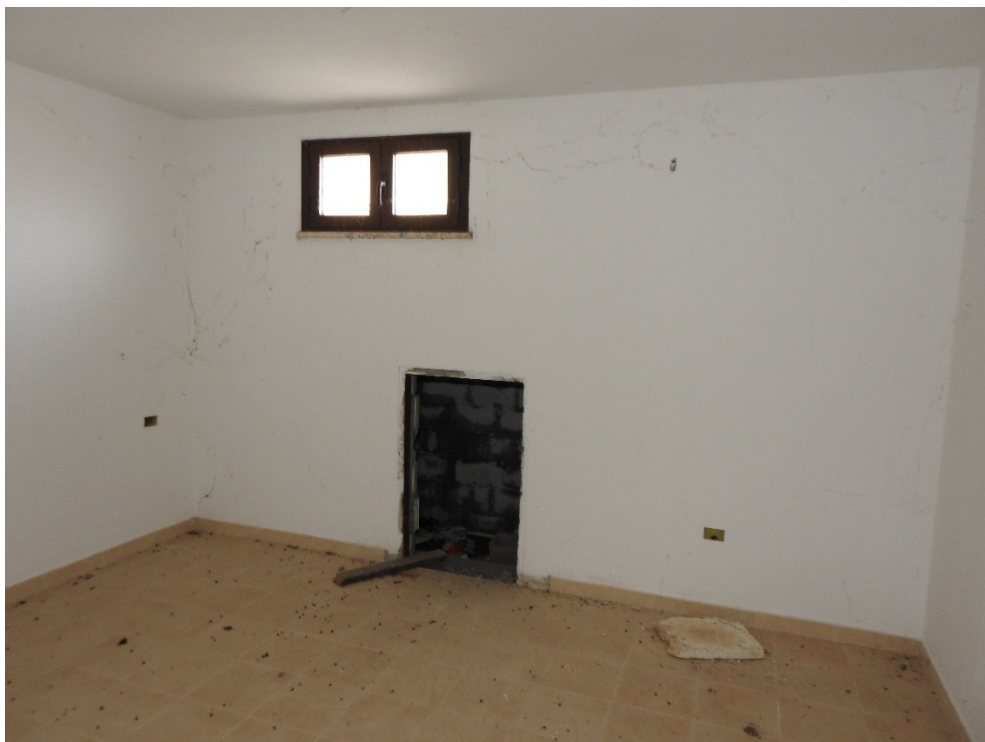
Figura 29 - Piano seminterrato, cantina.
