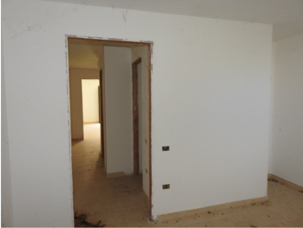
Figura 30 - Piano seminterrato, cantina
