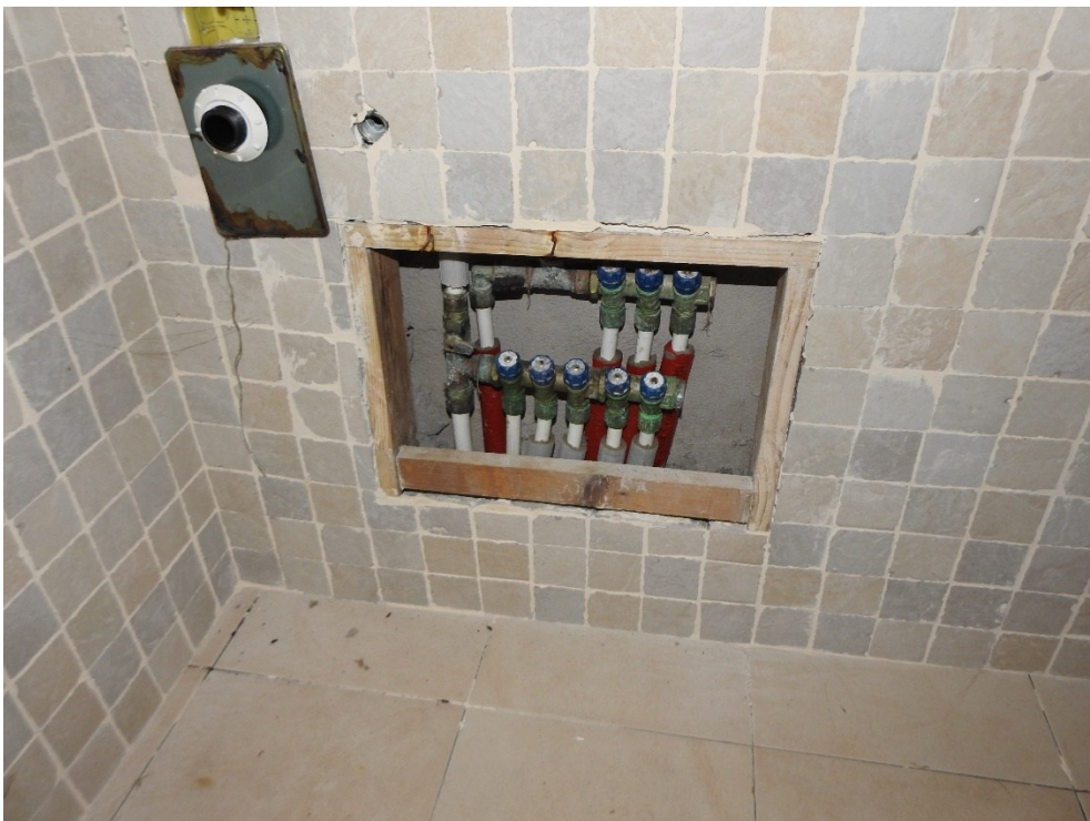
Figura 51 - Collettore impianto idrico piano seminterrato
