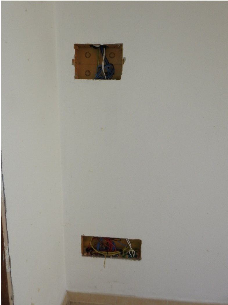
Figura 50 - Piano seminterrato e impianti non ultimati
