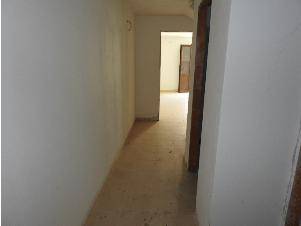
Figura 28 - Piano seminterrato, disimpegno
