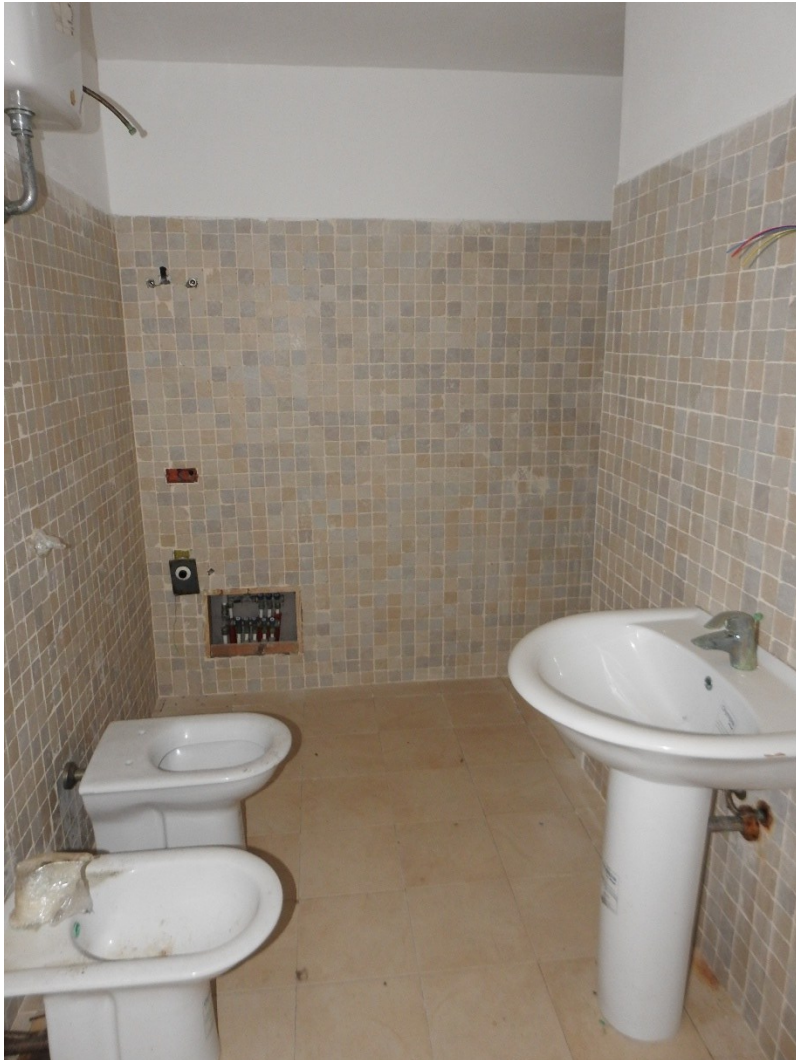
Figura 31 - Piano seminterrato, bagno
