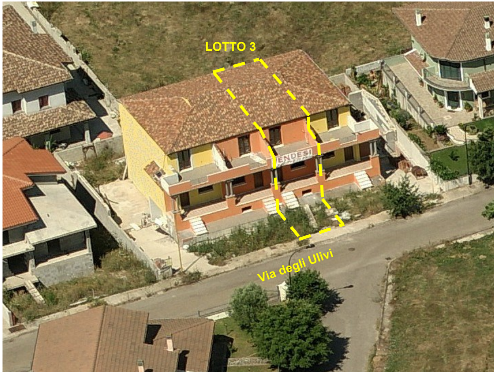
Figura 18 - Visuale complessiva del fabbricato, foto aerea
