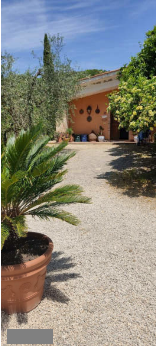
Foto 40 e 41 – vista eterna, prospetti ovest e nord
