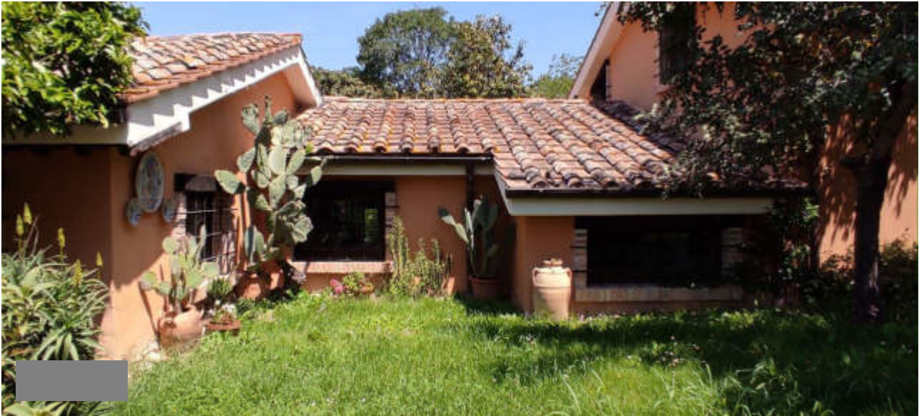
Foto 16 – Vista esterna, prospetto sud
