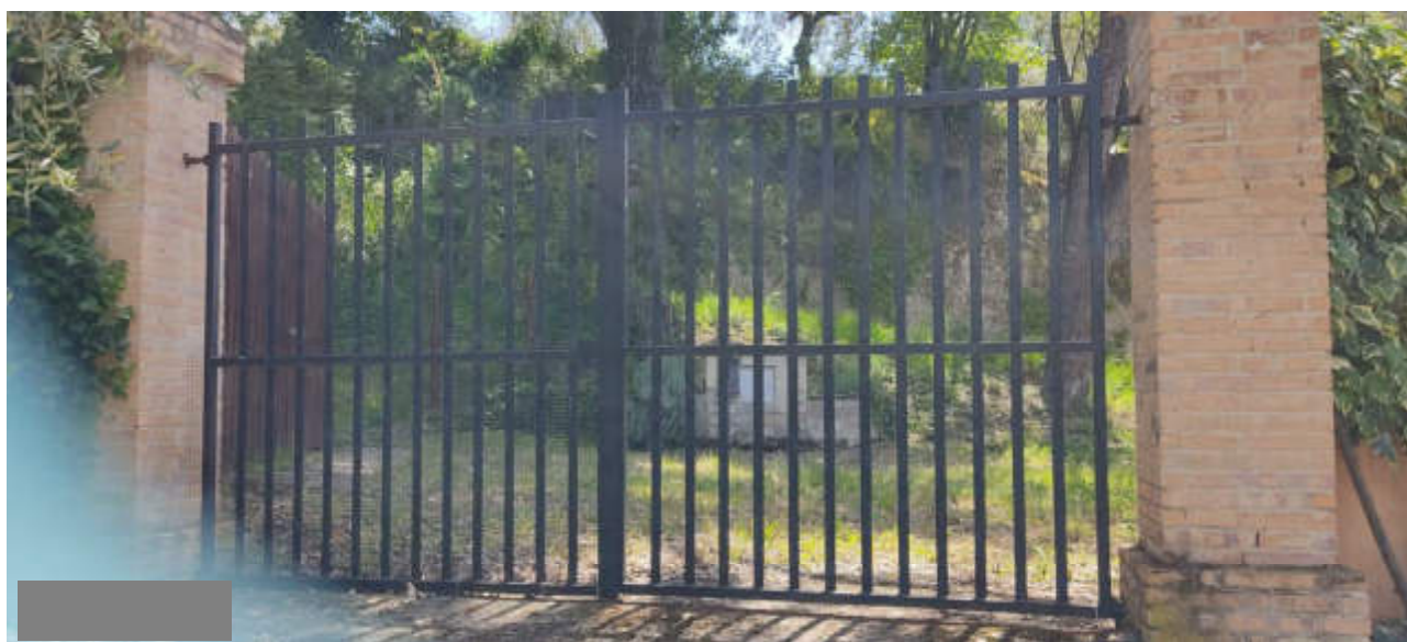
Foto 3-4 – Accesso carrabile dalla via comunale
