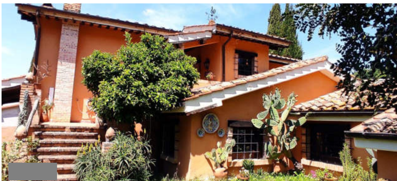
Foto 15 – Vista esterna, prospetto est
