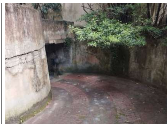
Foto 16 – rampa carrabile (chiusa)
