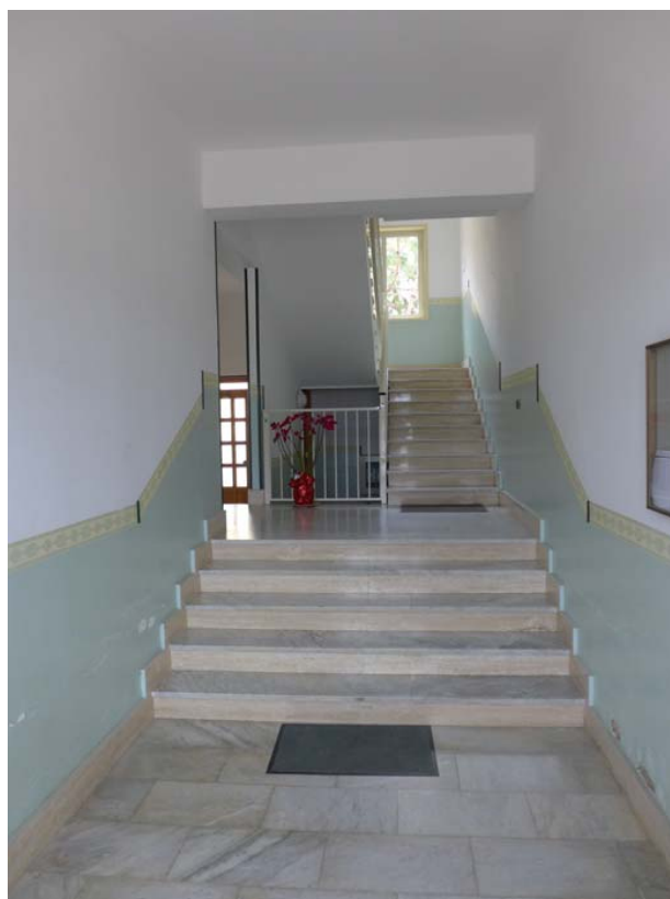
Foto n. 3 – Vano scala condominiale
