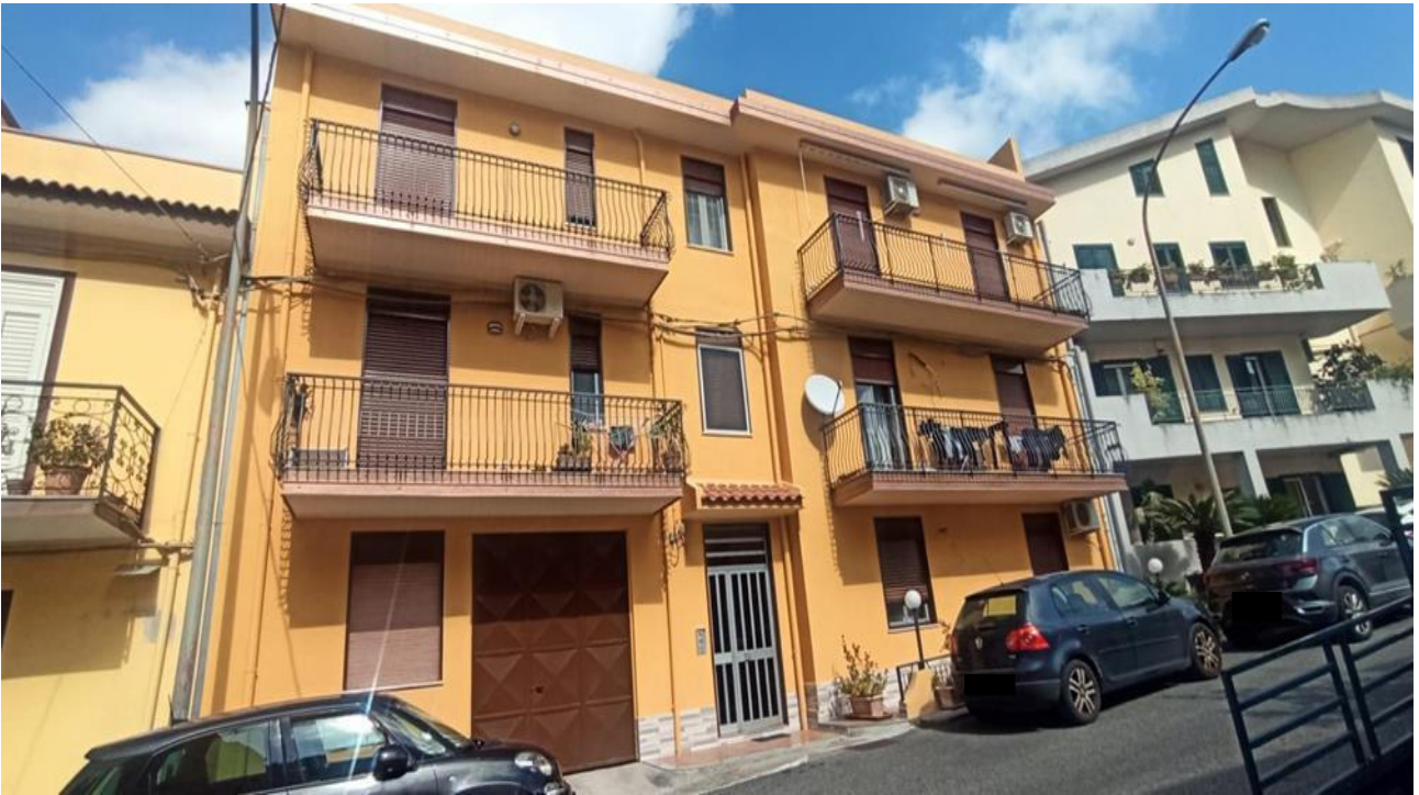
Foto 1 Prospetto principale via Roma Lato Nord
