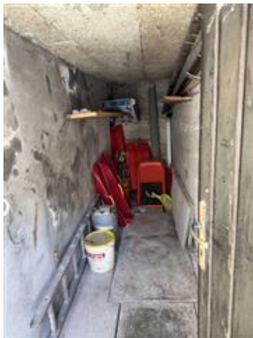
Vano servizi comune al piano terra
