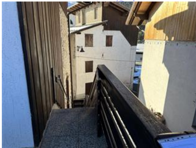
Scala di accesso al piano
