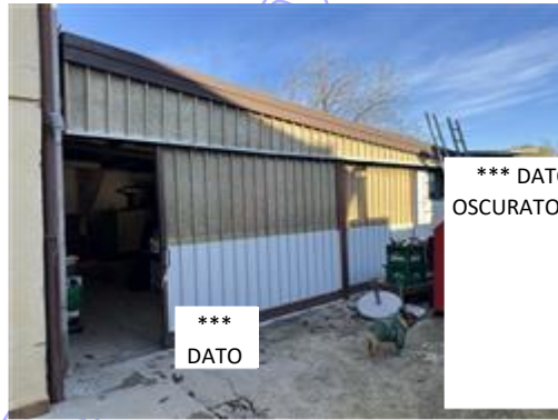
Fabbricato con struttura in ferro
