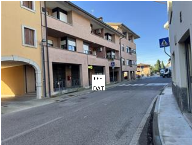
Veduta complesso immobiliare
