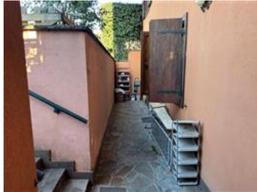
Accesso piano parzialmente interrato
