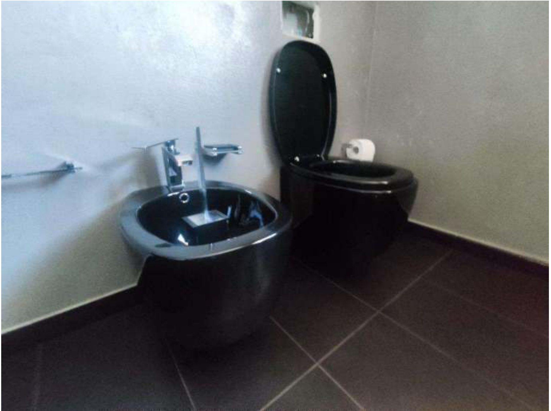
VISTE INTERNE PIANO PRIMO
