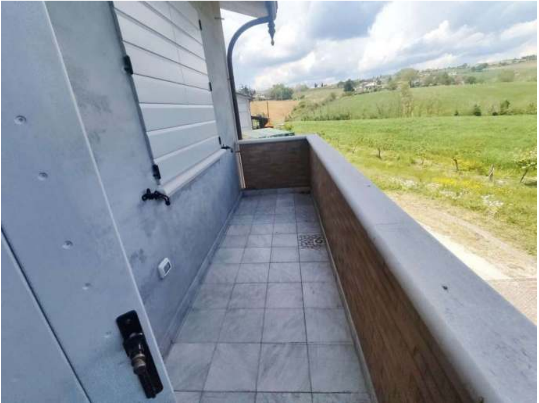
VISTE INTERNE PIANO PRIMO
