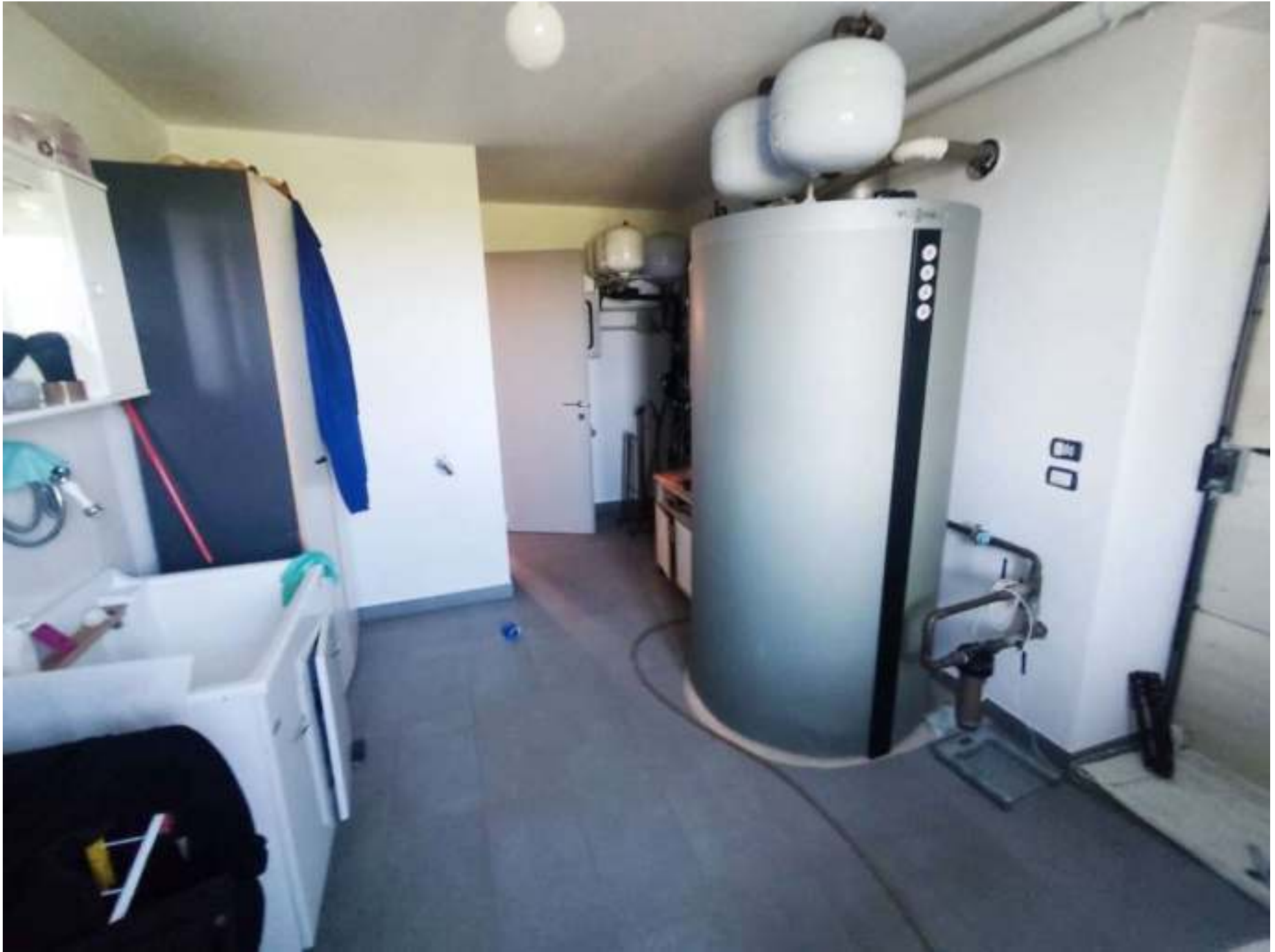
VISTE INTERNE PIANO TERRA
