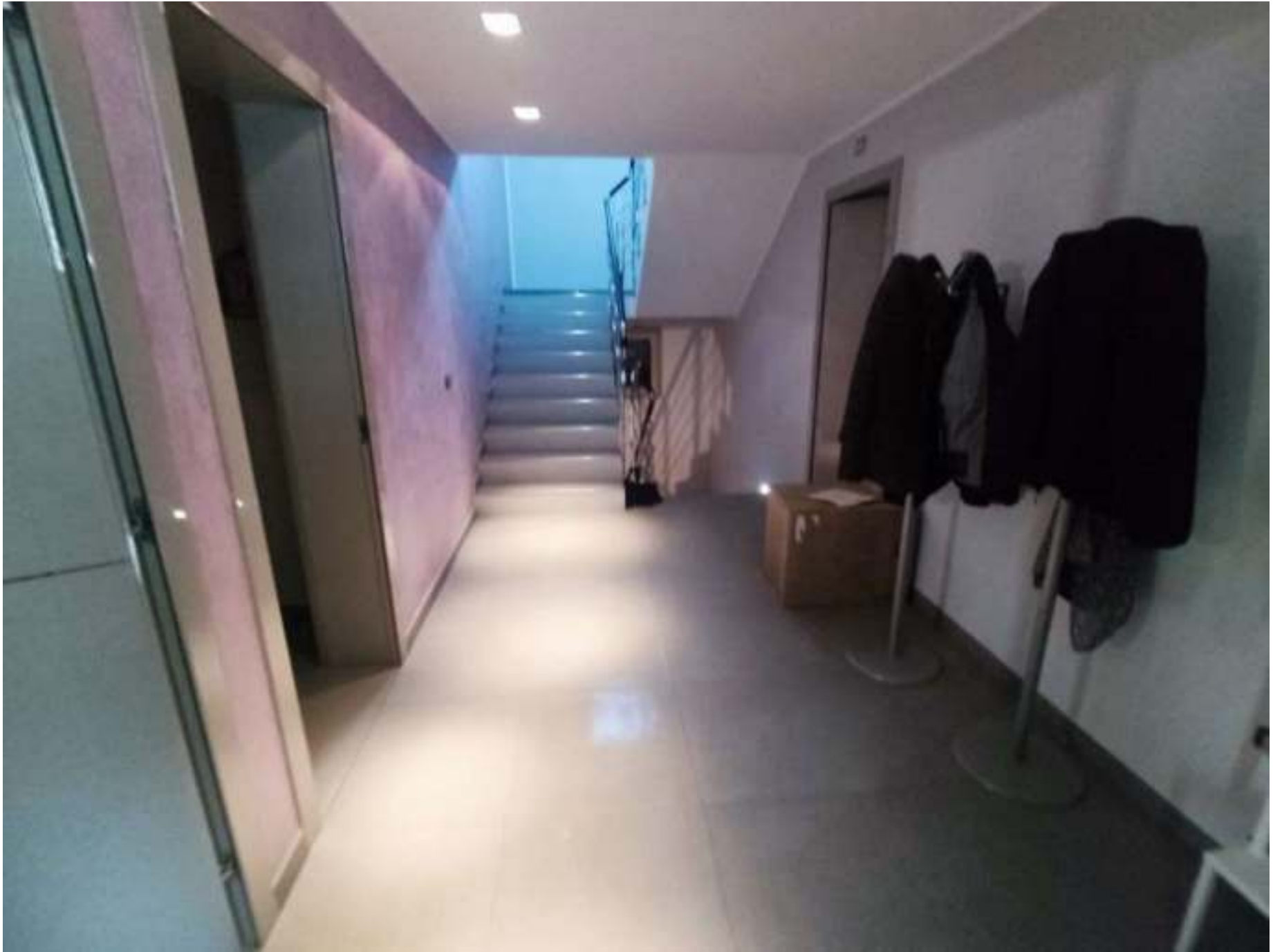
VISTE INTERNE PIANO TERRA
