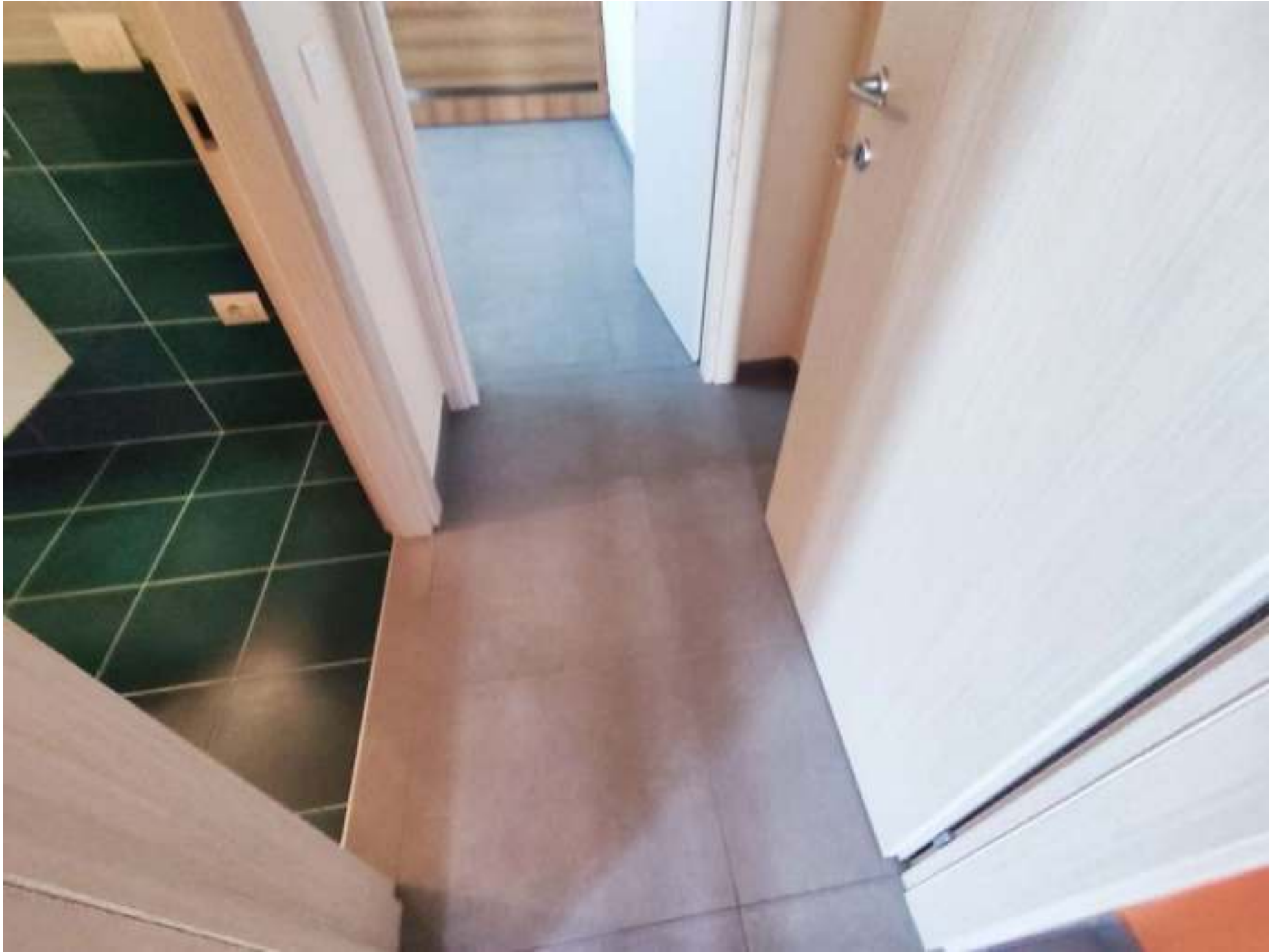
VISTE INTERNE PIANO TERRA
