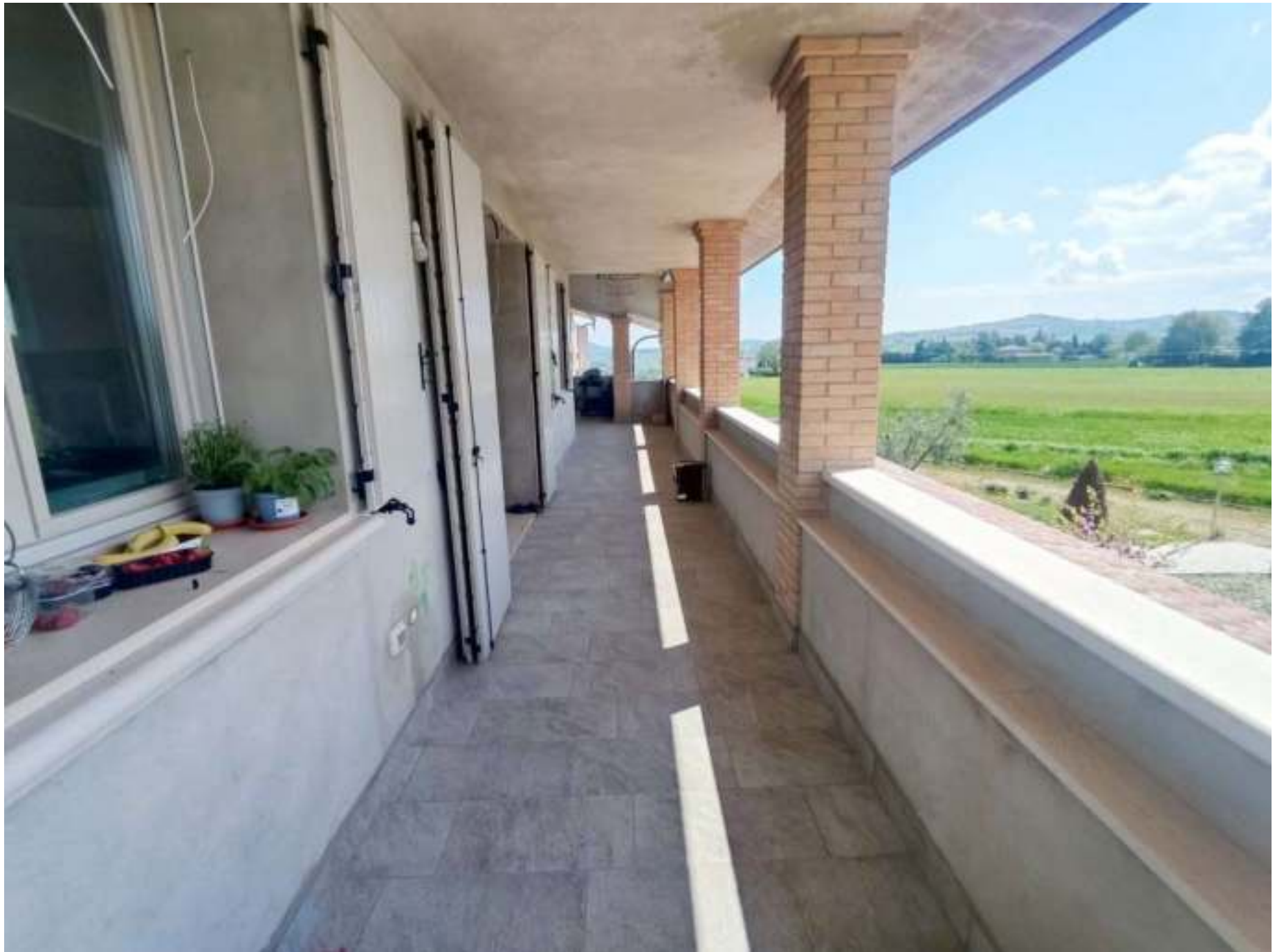
VISTE INTERNE PIANO PRIMO
