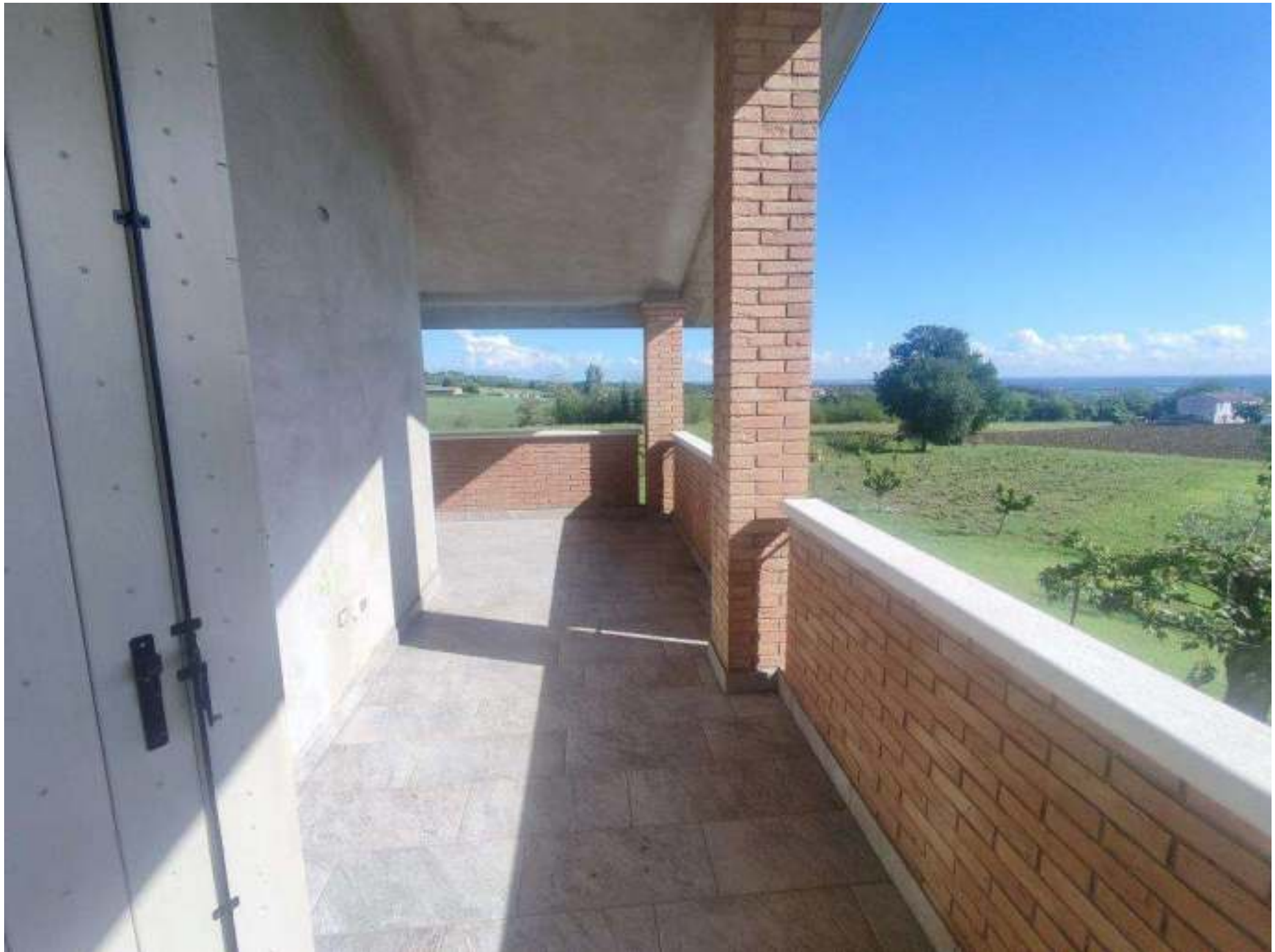
VISTE INTERNE PIANO PRIMO
