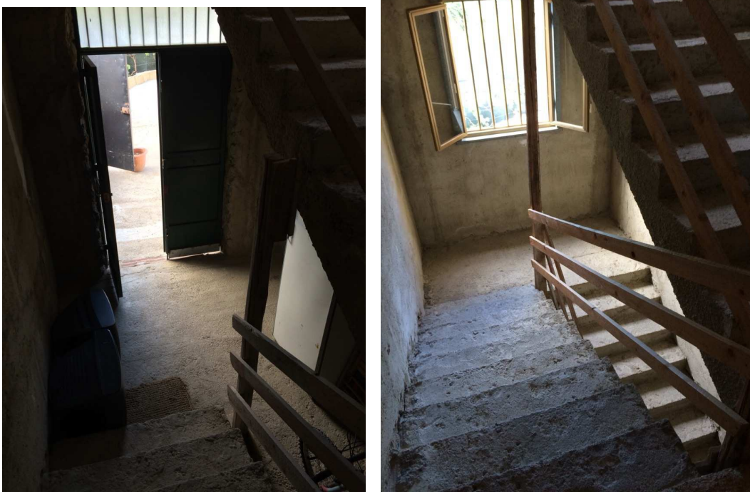
Foto interne immobile (vano scala)
