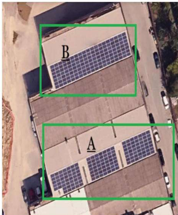
[6] Impianto fotovoltaico - Immagine estratta da sito web di "Google Earth"
