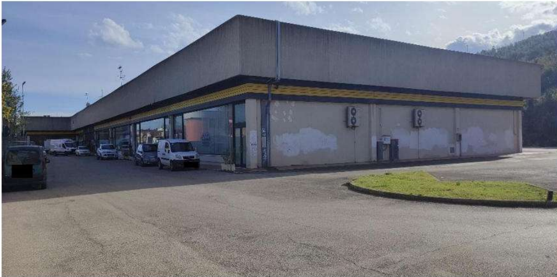
[4] Vista da Nord della porzione Nord del complesso immobiliare
