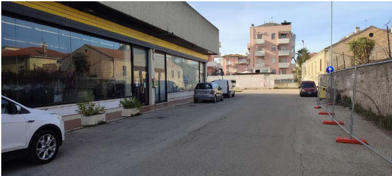
FOTO 1 - Vista prospettica da Sud-Est di porzione del complesso immobiliare
