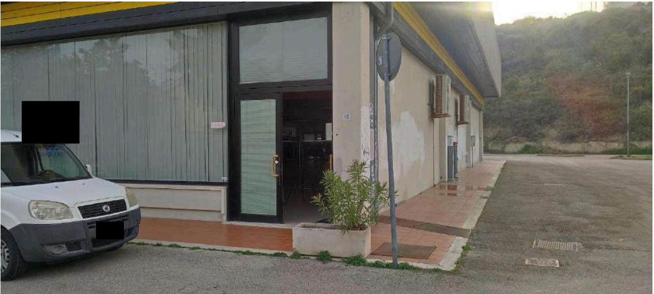
FOTO 5 - Ingresso principale all'unità immobiliare (subalterno 20)
