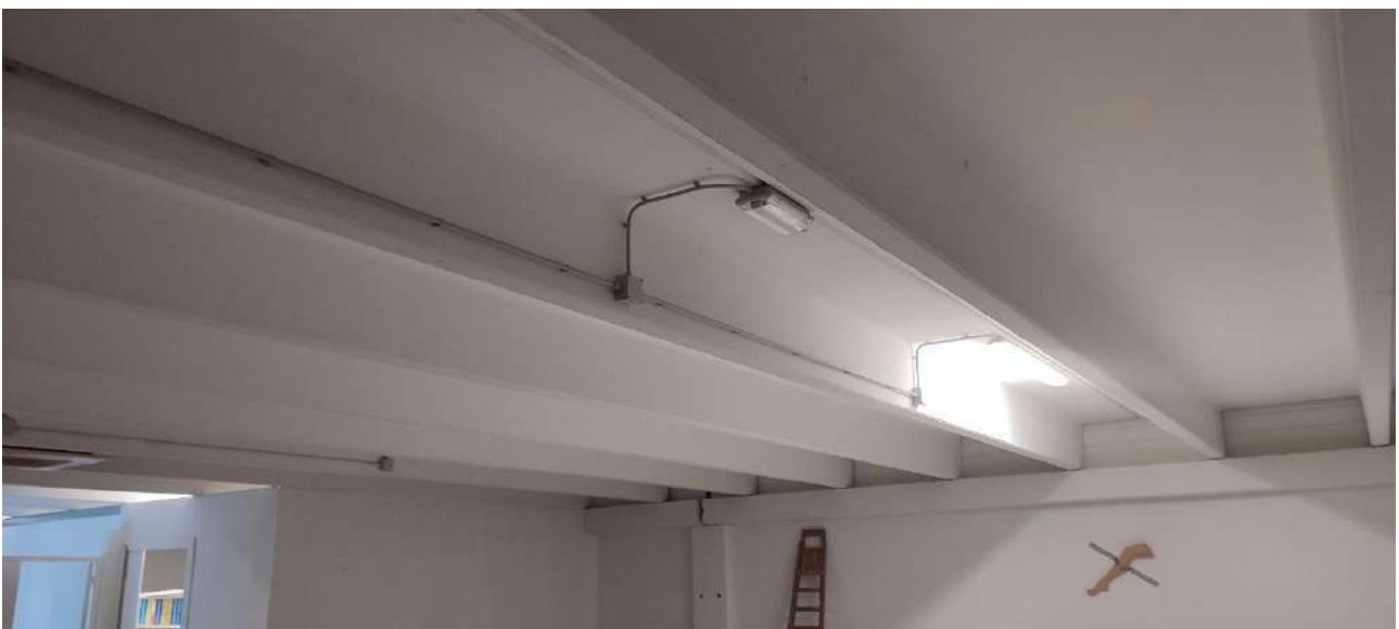
FOTO 16 - Piano primo soppalcato – intradosso copertura
