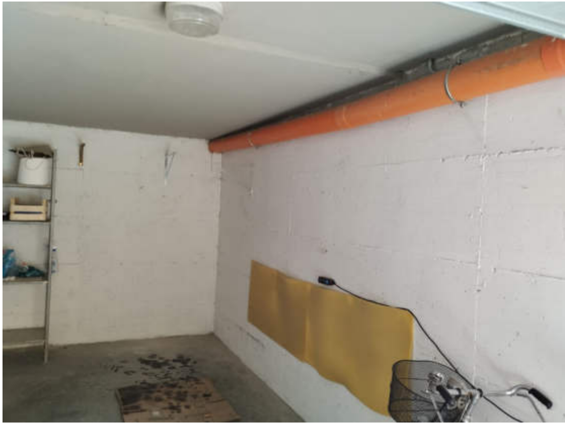
Vista interna della U.I.U. oggetto di valutazione
