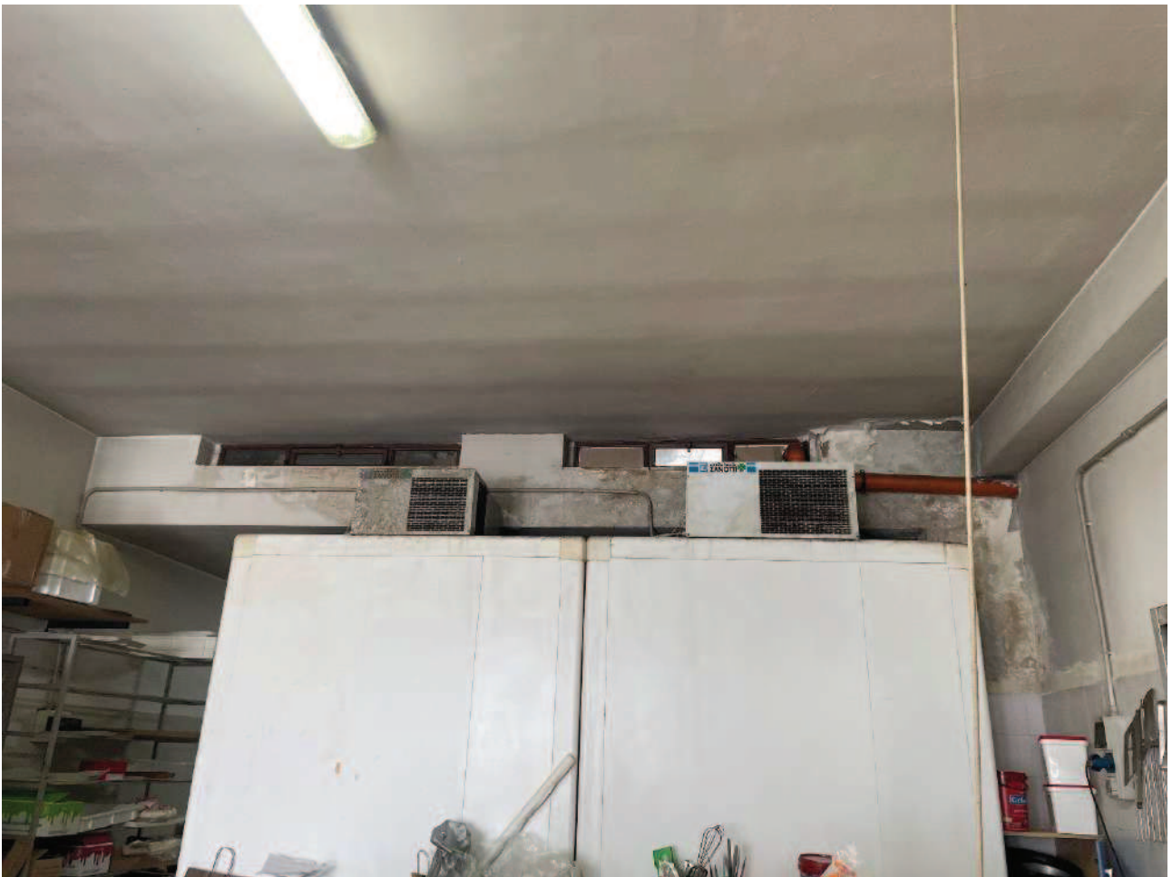
Figura 17. LOTTO DUE: Immobile pignorato al F. 63, P.Ila 491, Sub. 1 ubicato in San Severo alla Via G. D'Orsi n. 38 (macchie di umidità).
