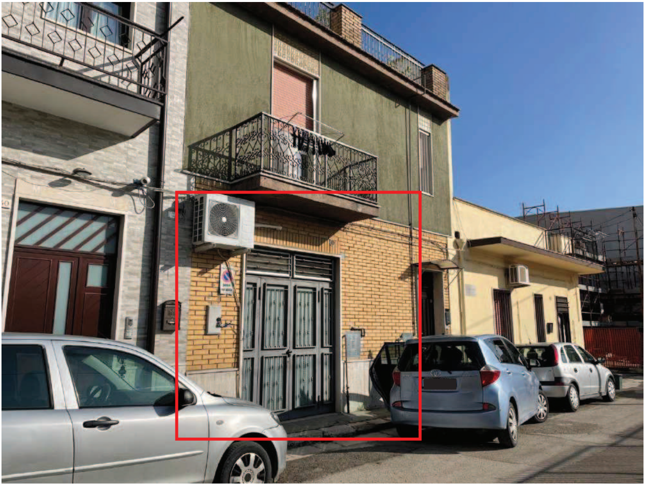
Figura 13. LOTTO DUE: Immobile pignorato al F. 63, P.Illa 491, Sub. 1 ubicato in San Severo alla Via G. D'Orsi n. 38.
