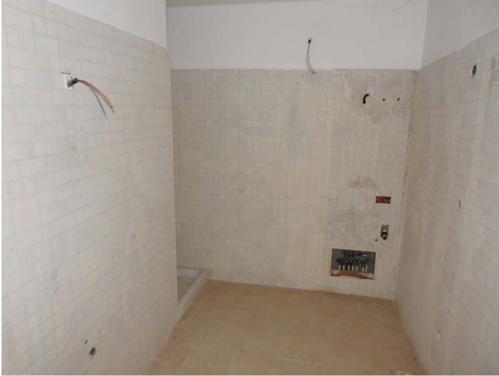
Figura 31 - Piano seminterrato, bagno
