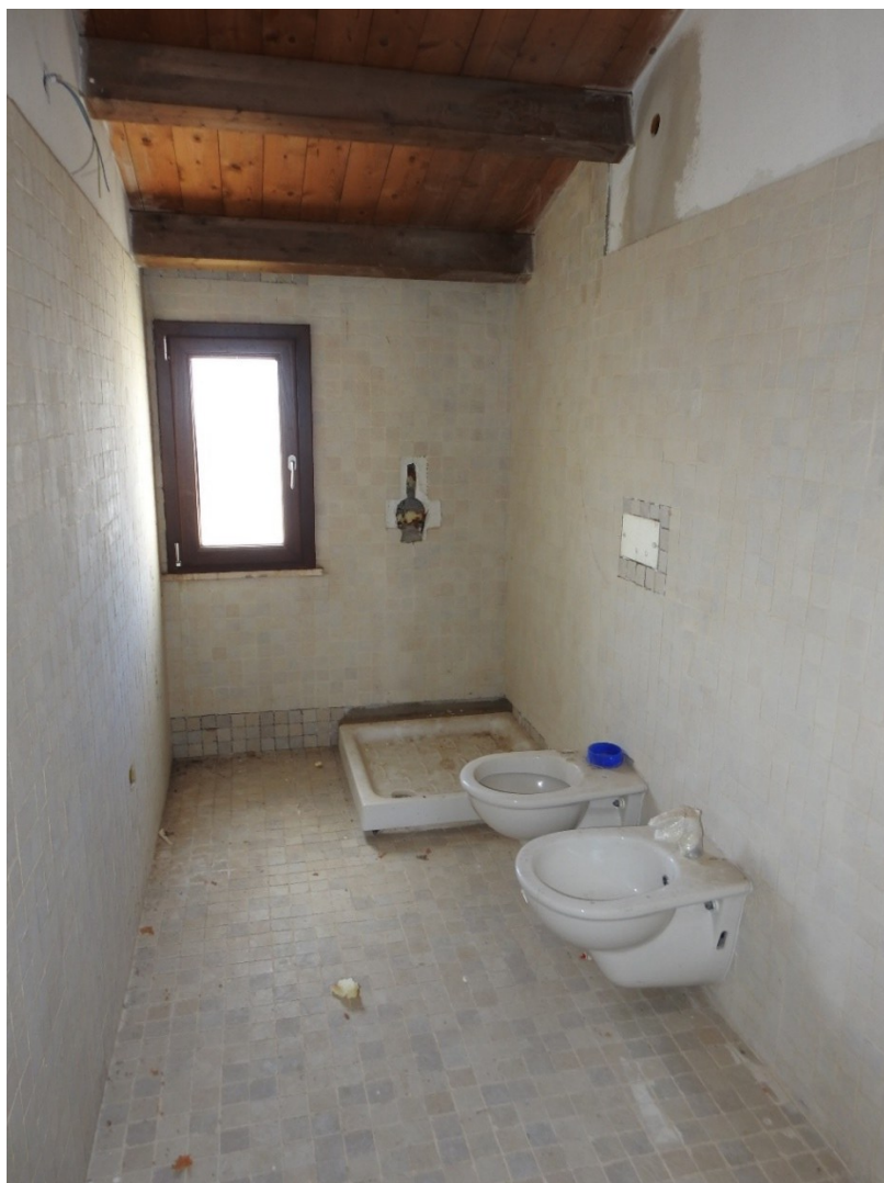
Figura 47 - Piano primo, bagno
