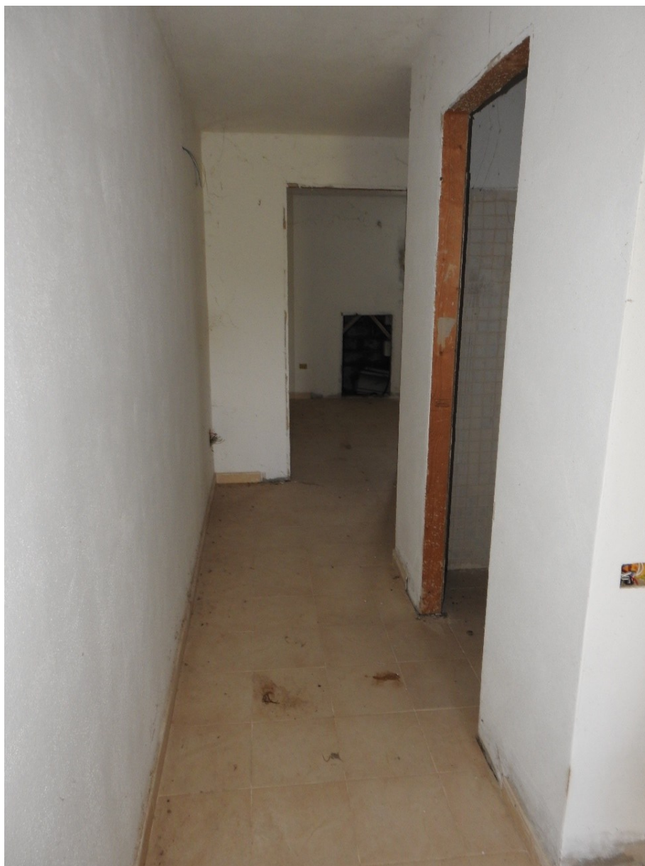
Figura 28 - Piano seminterrato, disimpegno
