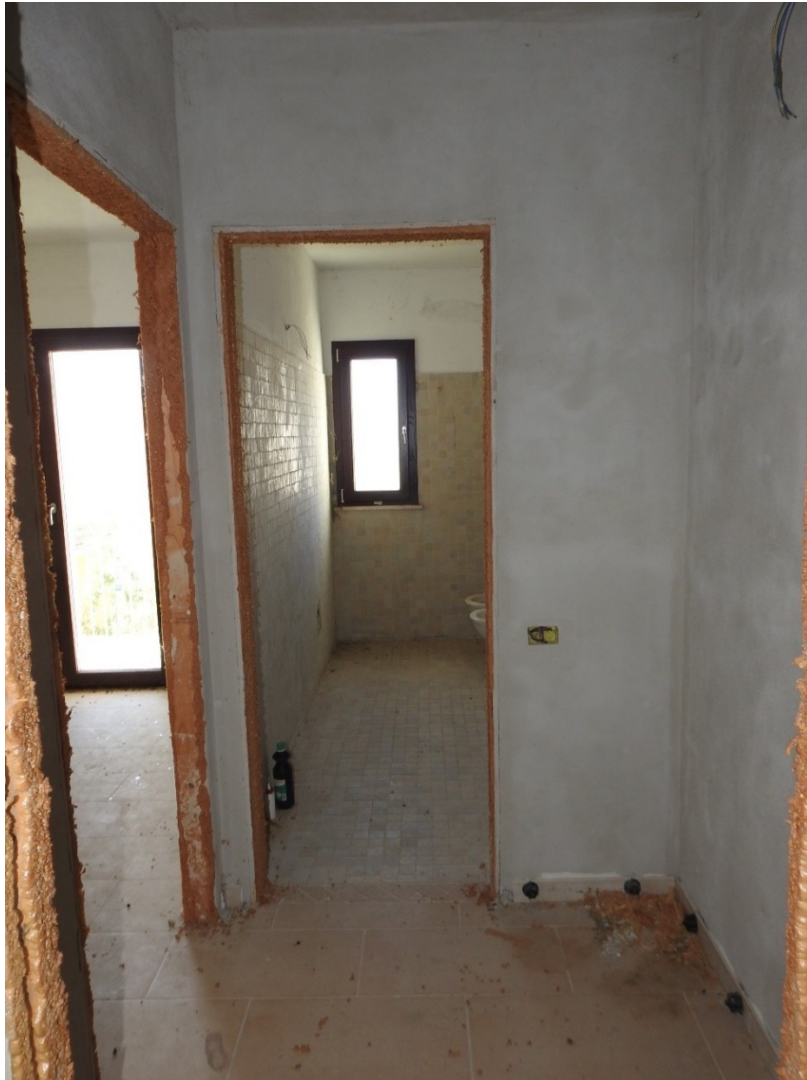
Figura 35 - Piano Terra, disimpegno bagno/cucina
