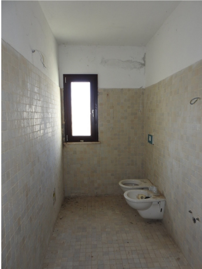
Figura 36 - Piano Terra, bagno
