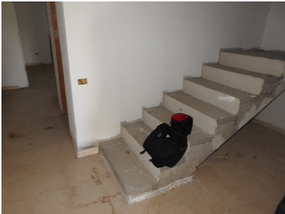
Figura 27 - Piano seminterrato, vano scala
