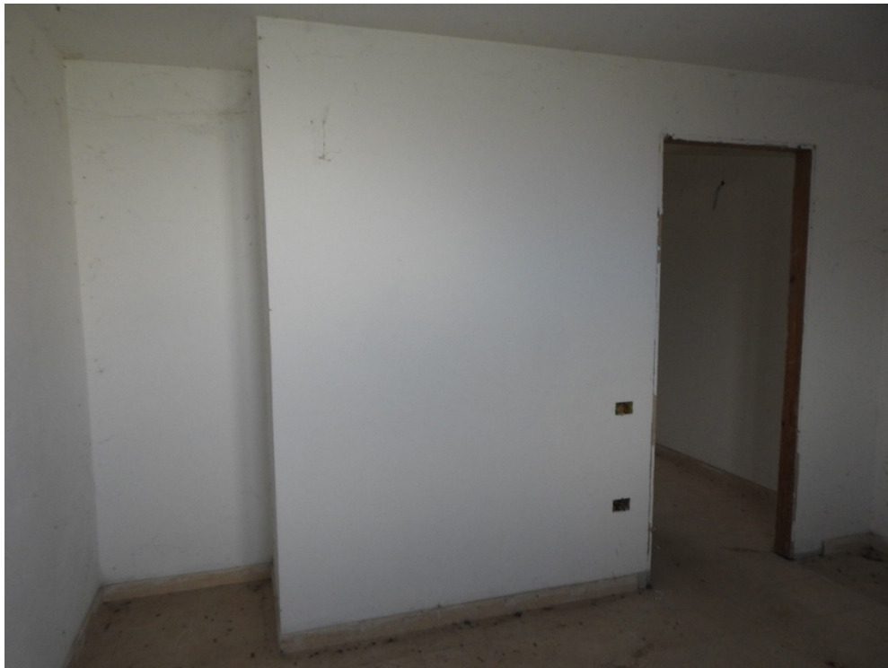
Figura 30 - Piano seminterrato, cantina
