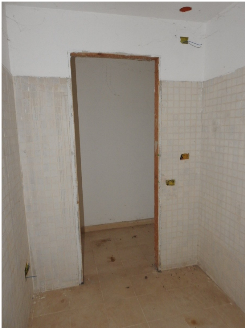
Figura 32 - Piano seminterrato, bagno
