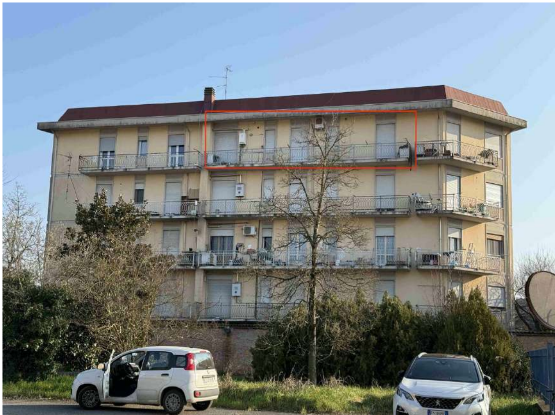
Retro palazzina (evidenziato in rosso il Bene n.1)
