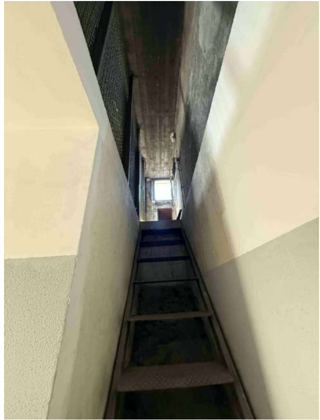
Rampa di accesso al piano quinto
