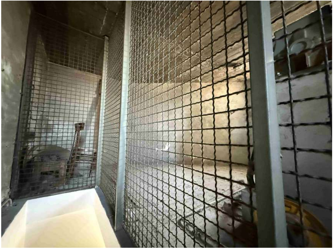
Vano Tecnico Ascensore al piano Quinto
