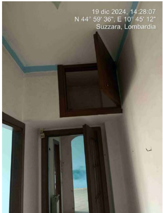
Particolare ribassamento soffitto atrio
