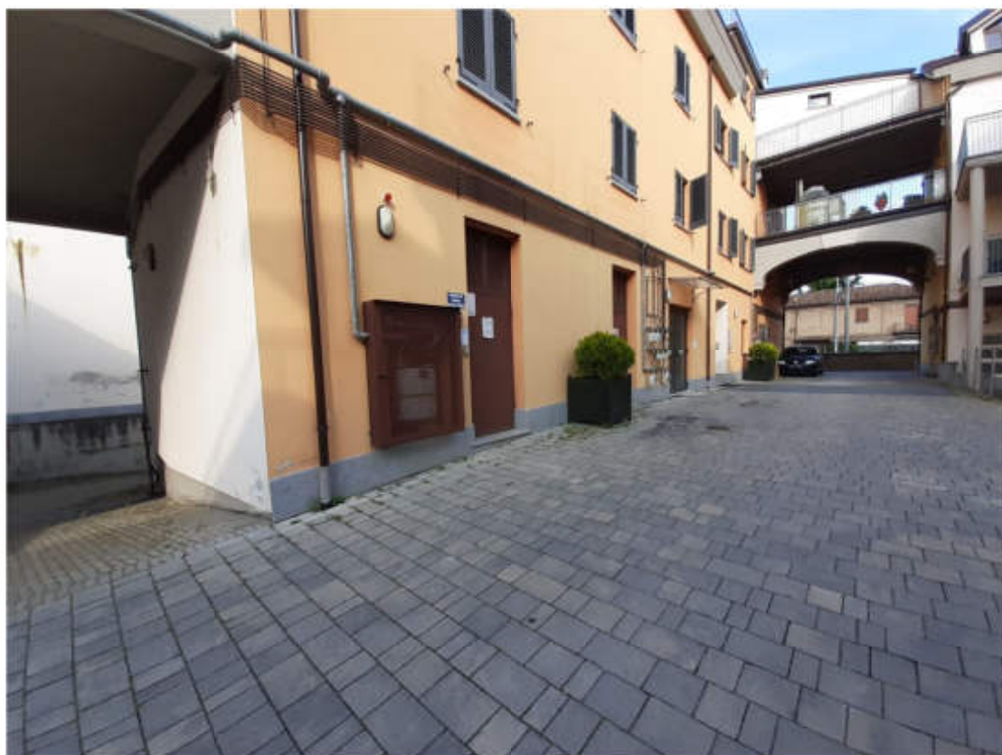
Vista dal cortile interno comune della rampa carraia di accesso al piano seminterrato
