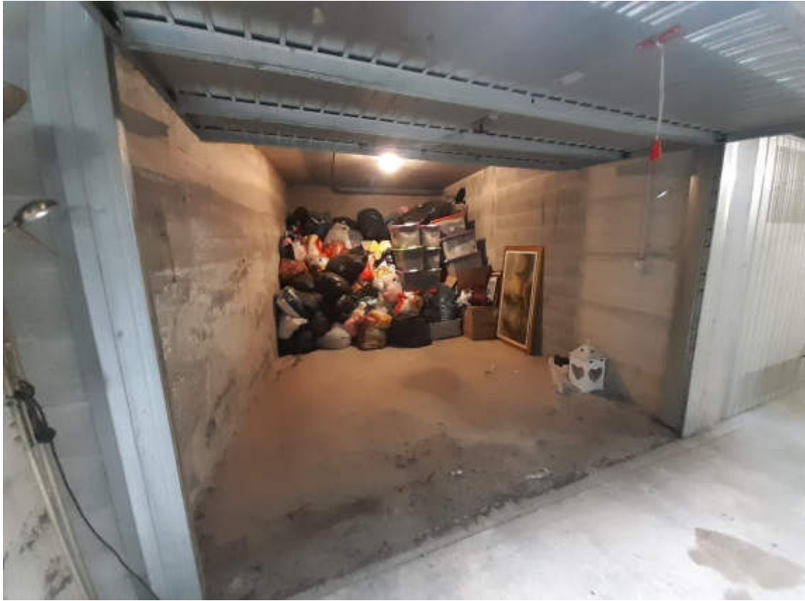
Vista interna della U.I.U. oggetto di valutazione
