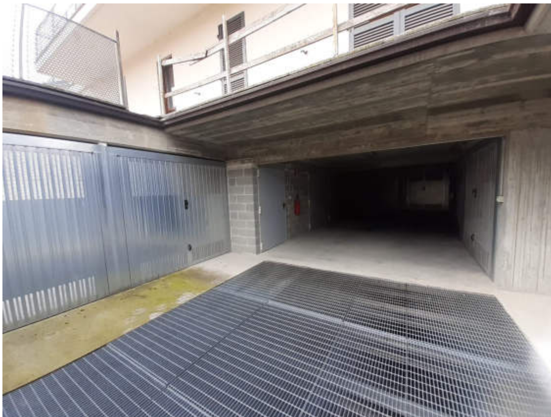
Vista interna della corsia comune di accesso al piano terra rialzato
