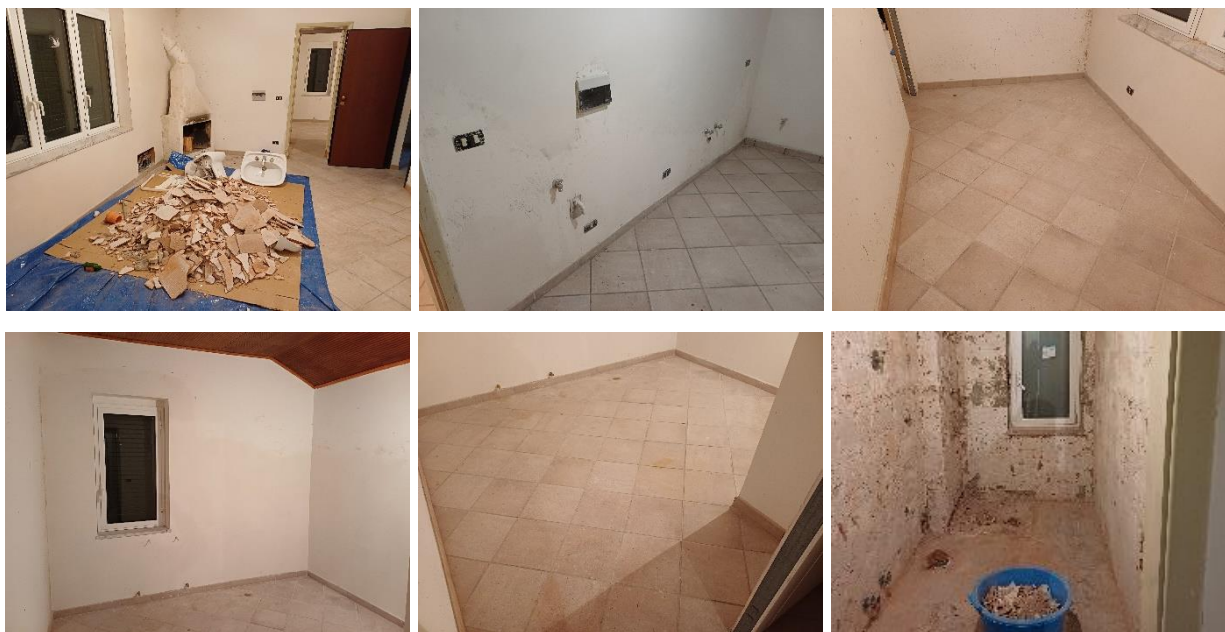
Vista di alcuni locali interni dell'abitazione (riproduzione completa in All.03b ).
