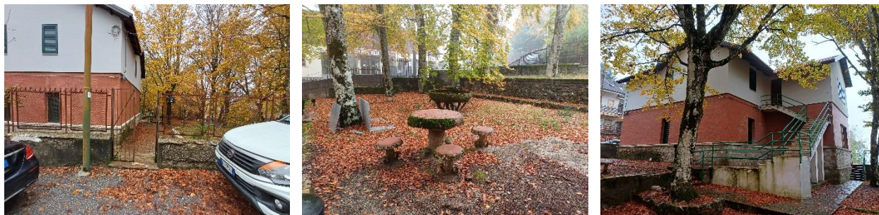
Vista esterna dell'ingresso pedonale, dell'area di pertinenza esclusiva del subalterno 10 e della scala di accesso al piano primo (ripresa completa in All.03a ).
